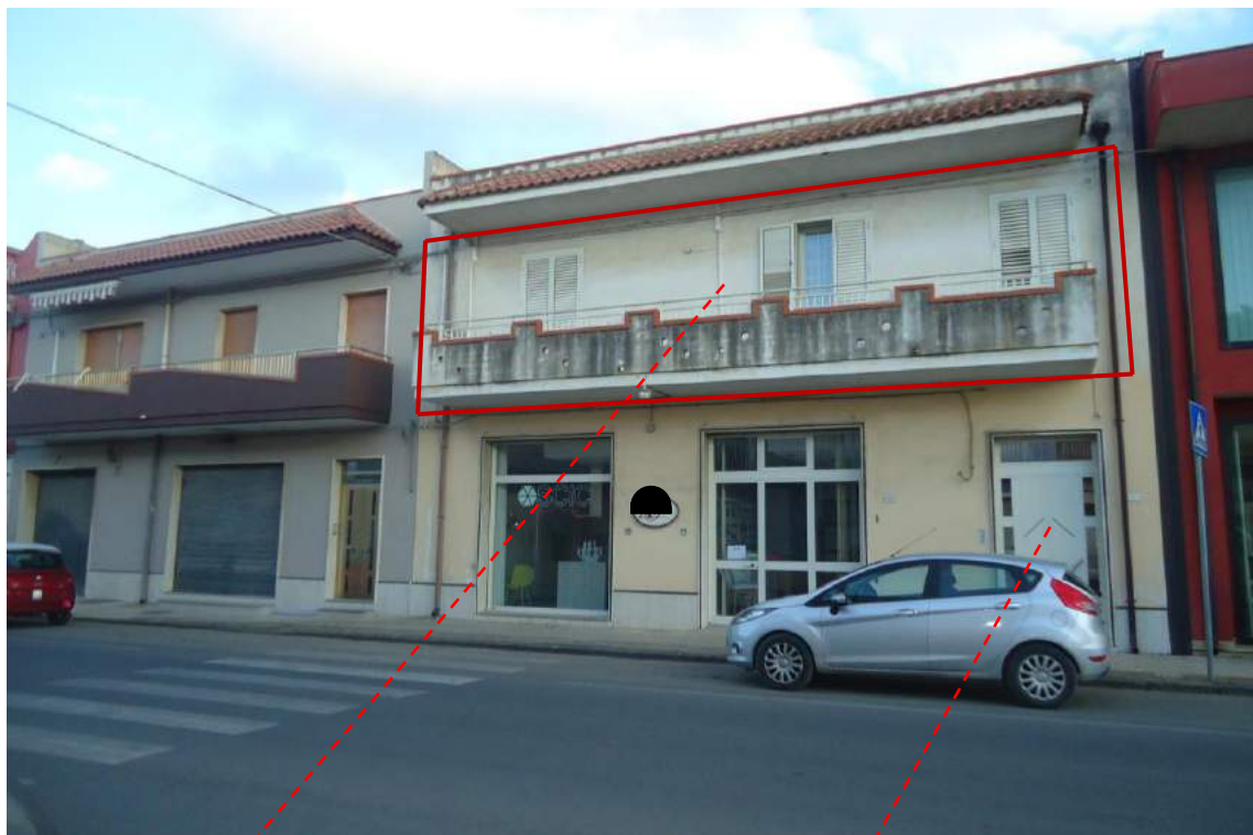
Foto n. 3 – Edificio di via Nazionale, Cassibile
