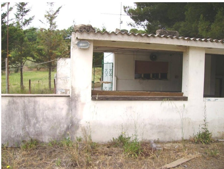
Vista esterna vano bar
