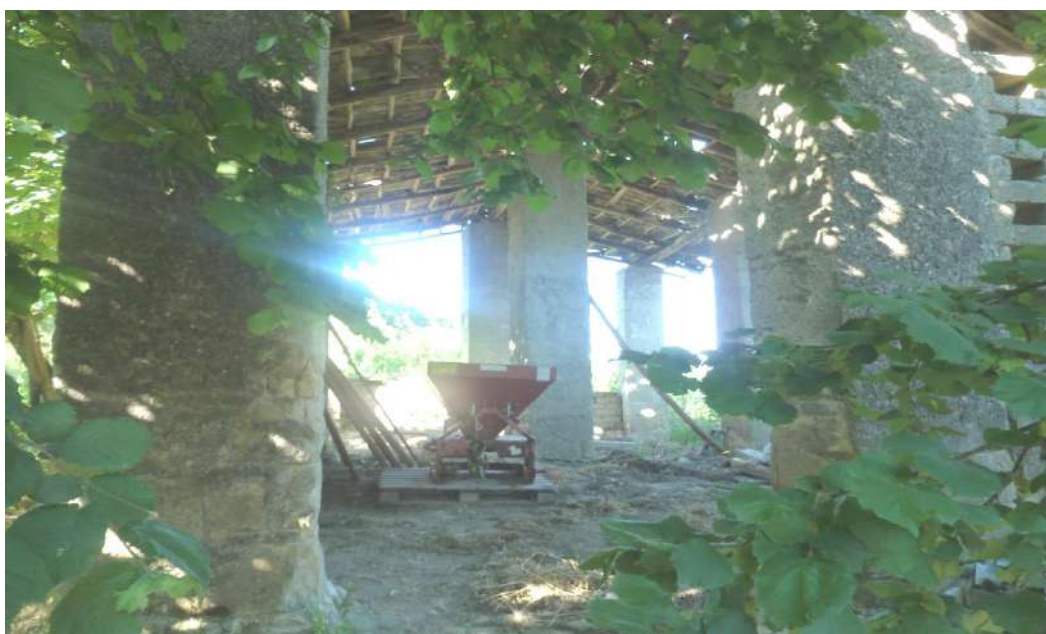
Foto n. 44 (Tettoia isolata in muratura semi-collabente part. 1038/6)
