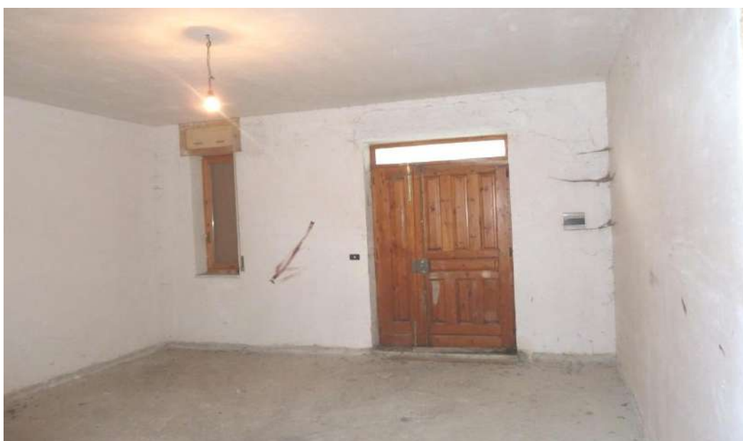
Foto n. 21 (Interno deposito part.lla 810; vano al piano terra)
