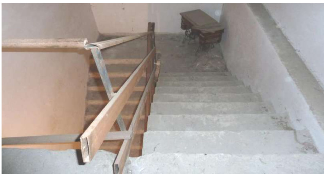
Foto n. 20 (Interno deposito part.lla 810; scala collegamento dal piano terra al seminterrato)
