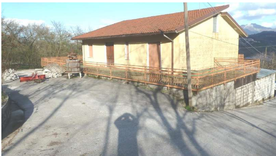
Foto n. 14 (Interno azienda- Vista frontale del fabbricato ad uso deposito agricolo part.ile 810 e 1032)
