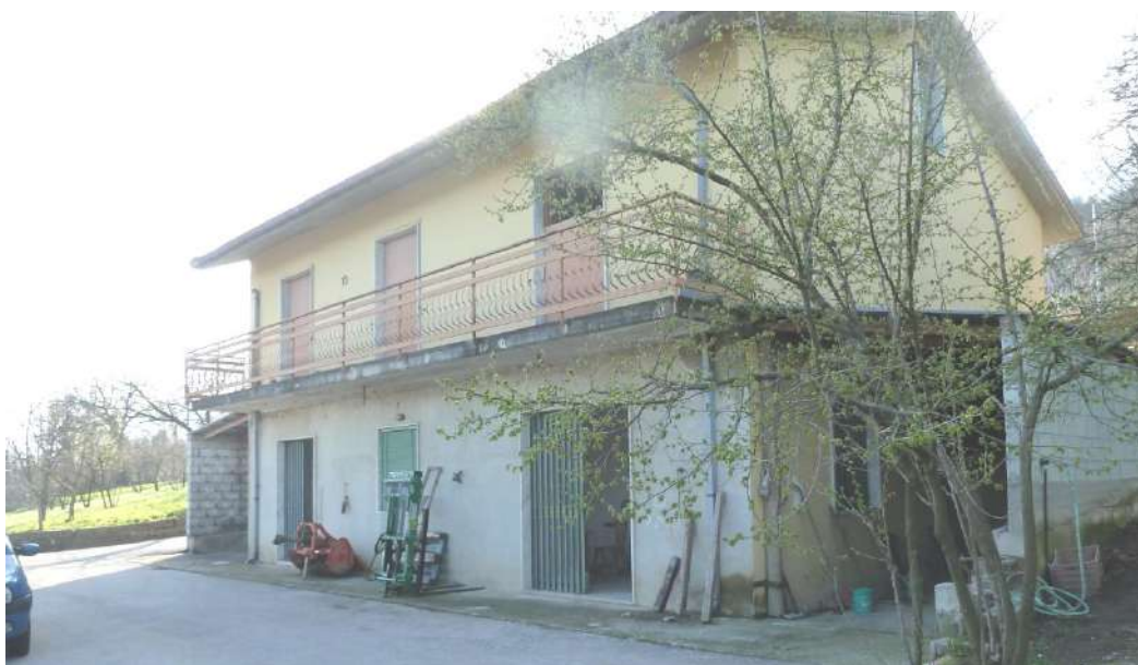
Foto n. 15 (Interno azienda- Vista posteriore del fabbricato ad uso deposito agricolo part.ile 810 e 1032)
