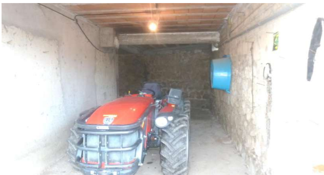
Foto n. 35 (Interno fabbricato colonico part.IIa 1038 –piano semint.to – rimessa mezzi agricoli)
