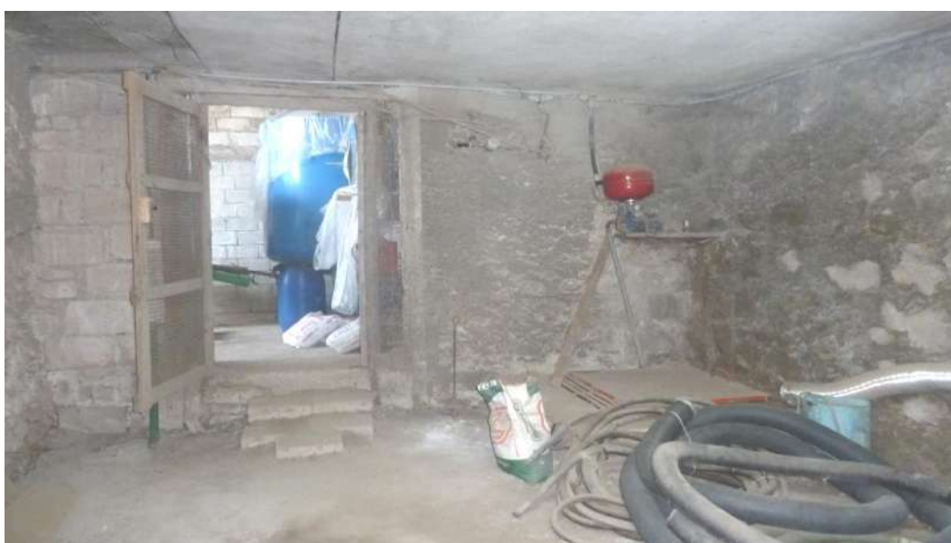
Foto n. 41 (Interno fabbricato colonico part.IIa 1028 –piano semint.to – cantine/depositi)
