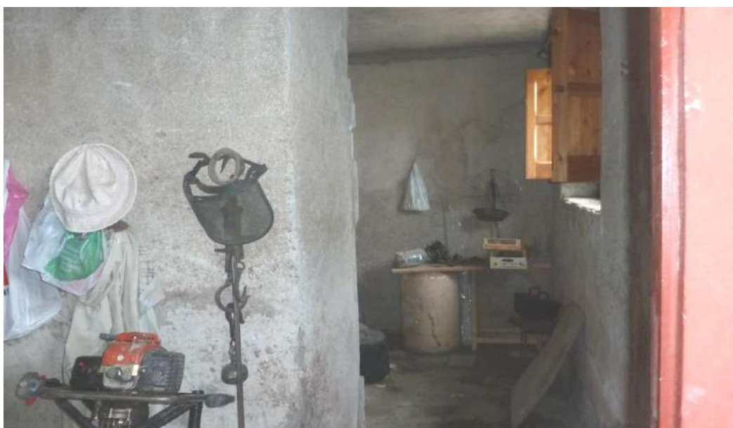
Foto n. 39 (Interno fabbricato colonico part.IIa 1028 /1038 –piano semint.to – cantine/depositi)
