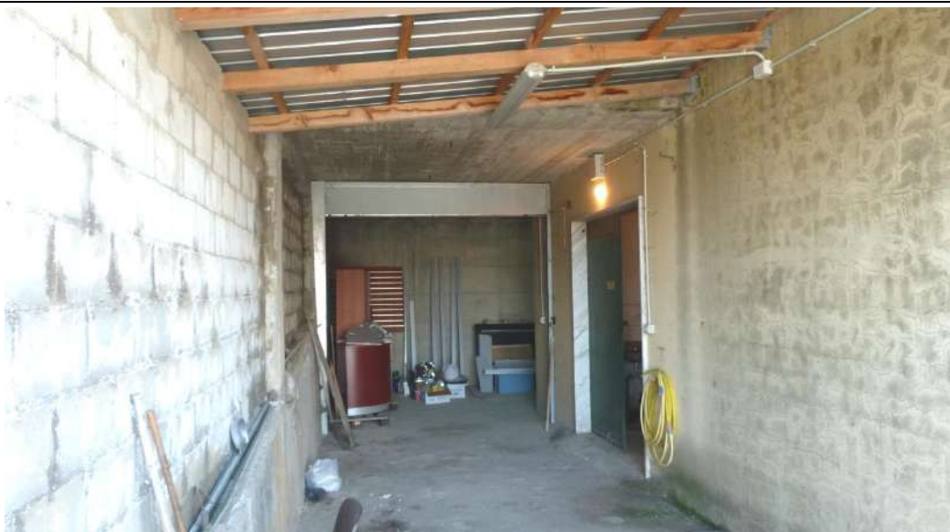
Foto n. 16 (Interno deposito part.lla 1032 vano al piano seminterrato)
