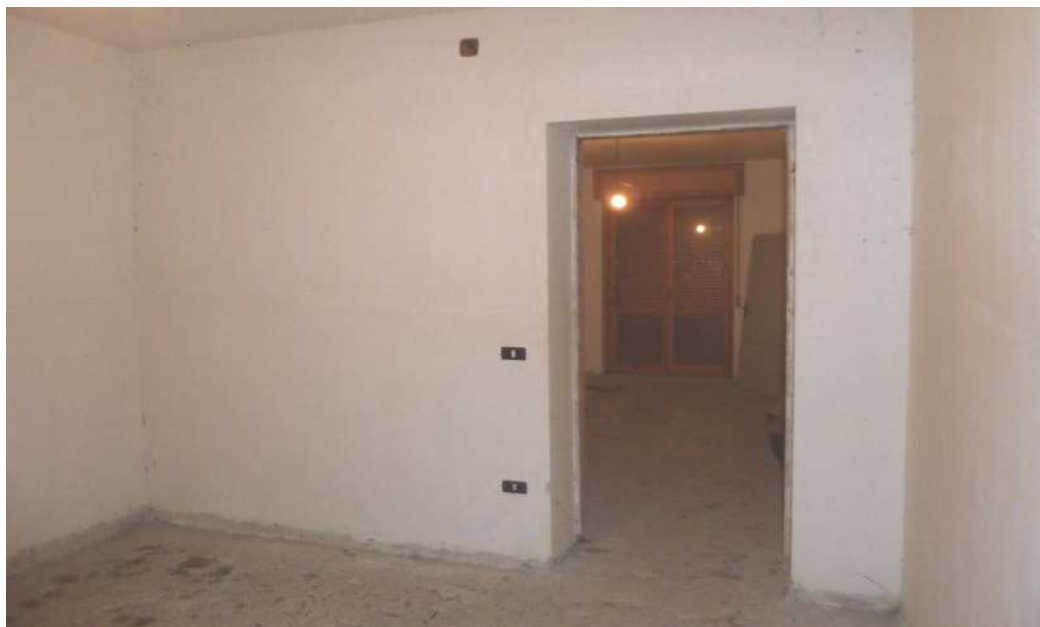
Foto n. 23 (Interno deposito part.Ila 810; vano al piano terra)
