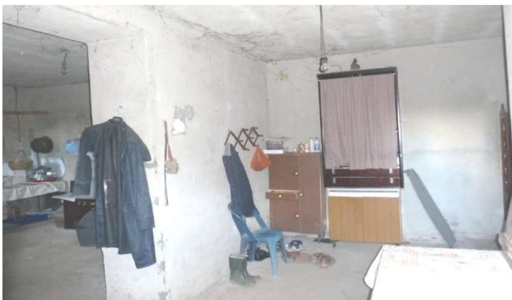
Foto n. 38 (Interno fabbricato colonico part.IIa 1038 –piano semint.to – cantine/depositi)
