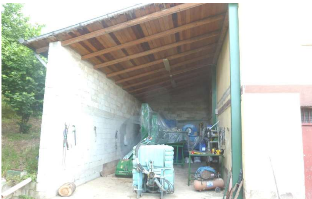
Foto n. 42 (Interno fabbricato colonico part.IIa 1028 –piano semint.to – tettoia/deposito)
