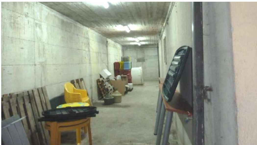
Foto n. 17 (Interno deposito part.lla 1032 vano al piano seminterrato)
