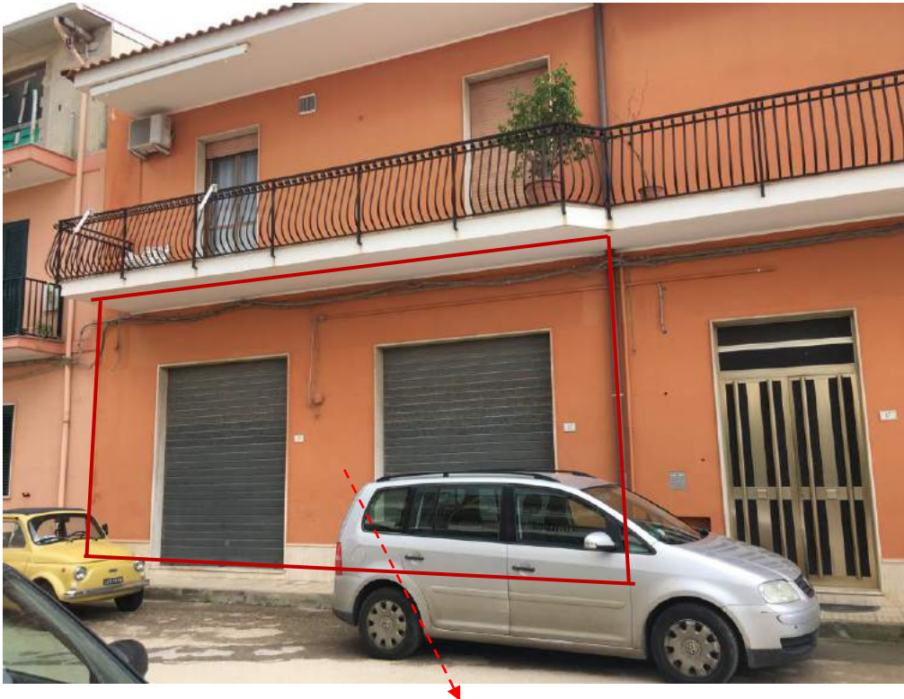
Foto n. 3 – Edificio di via dei Fiordalisi, Cassibile
