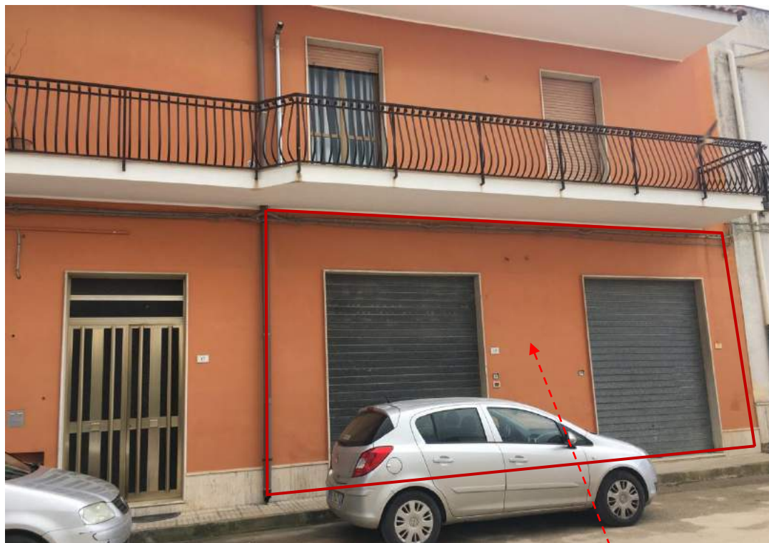
Foto n. 3 – Edificio di via dei Fiordalisi, Cassibile
