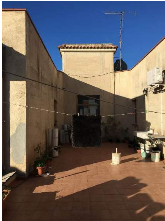
Foto n. 9 – Terrazza del piano primo.
