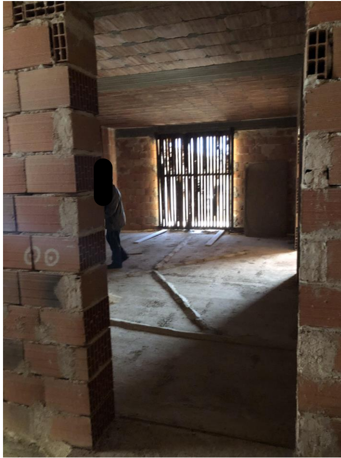
Foto n° 5 – Ingresso appartamento sub 11
