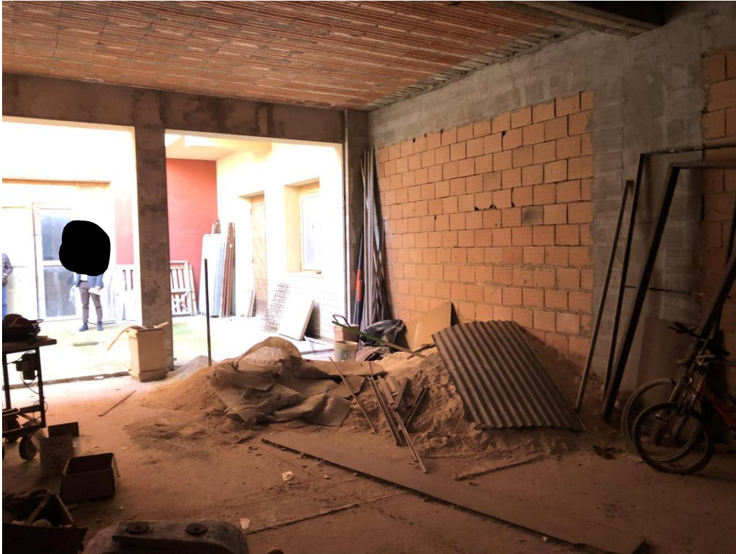
Foto n° 3 – Magazzino porzione sub 16
