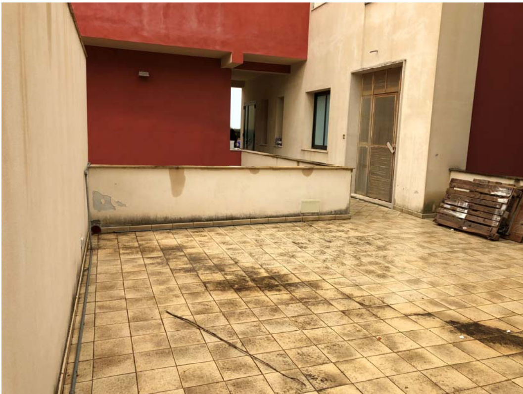
Foto n° 18 – Cortile esterno piano terra
