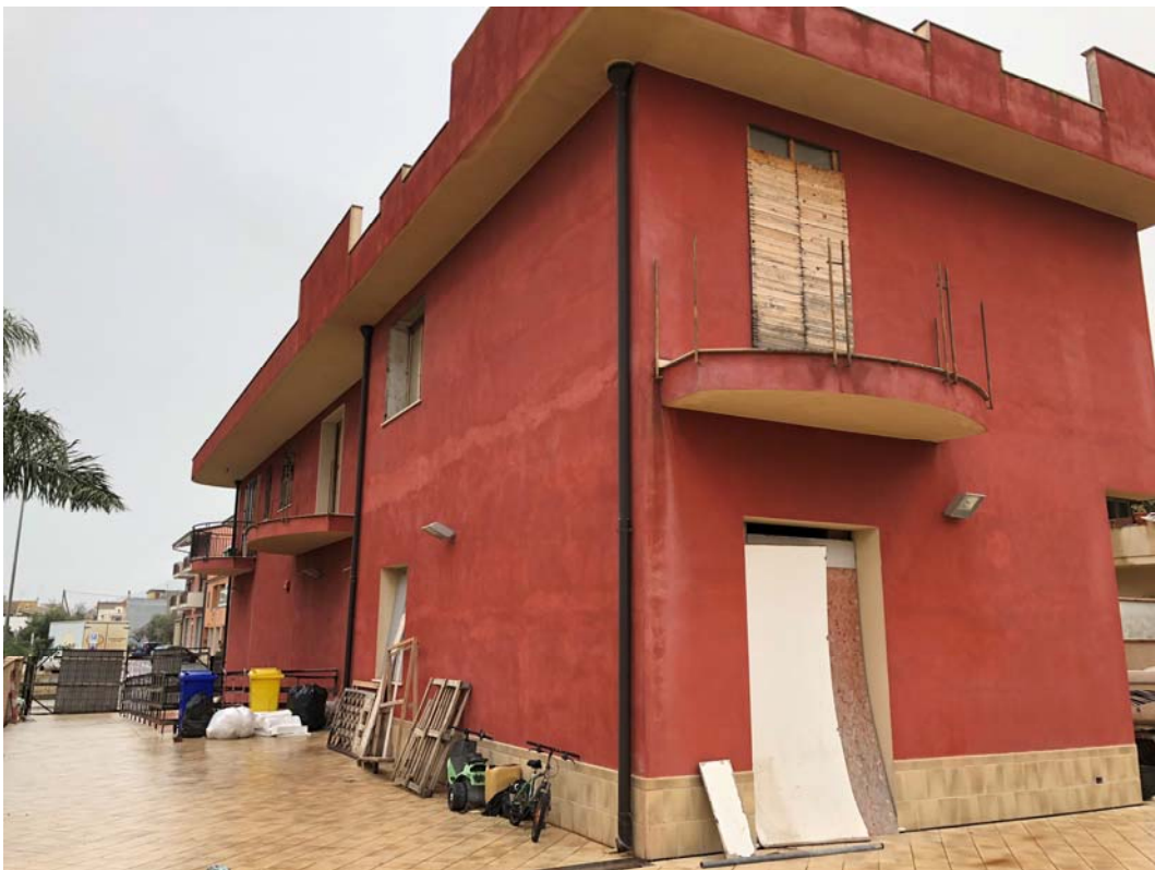
Foto n° 2 – Magazzino al piano terra
