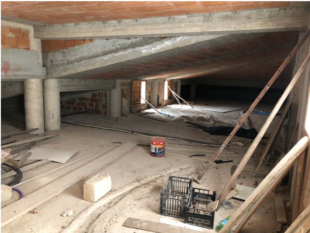
Foto n° 16 – vano tecnico sottotetto
