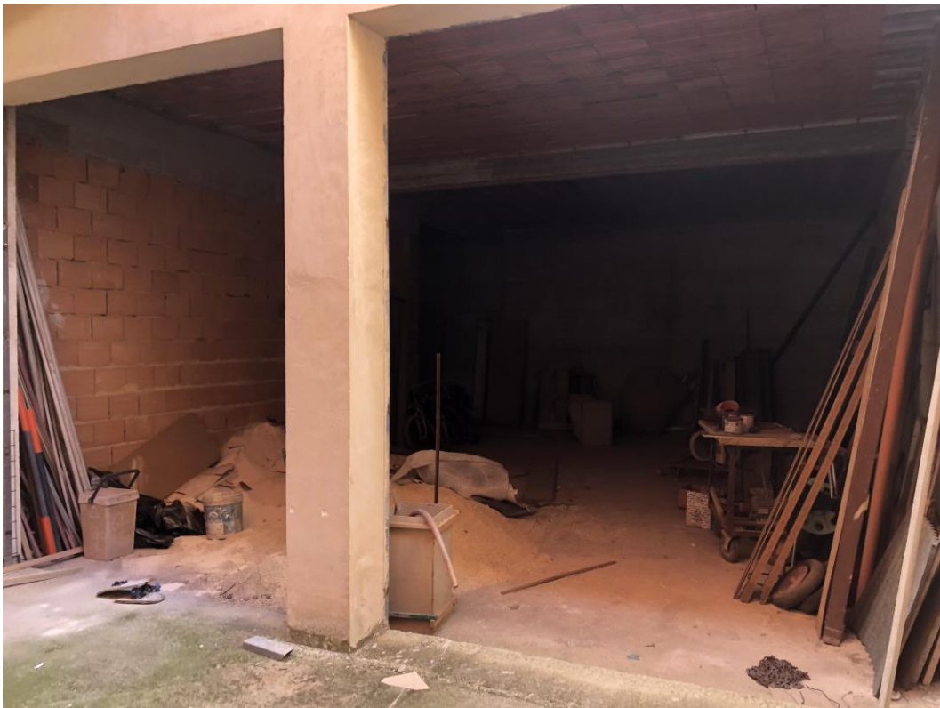
Foto n° 2 – Magazzino porzione sub 16
