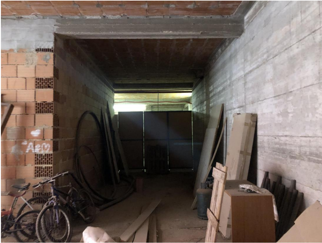
Foto n° 1 – Magazzino porzione sub 16
