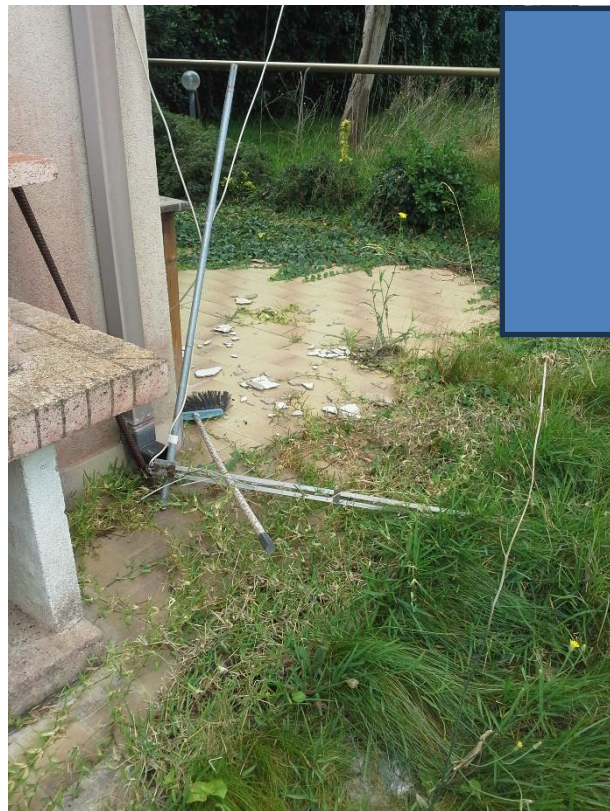
Foto n. 35/37 – Viste del cornicione danneggiato su cui era stata ancorata l'antenna TV
