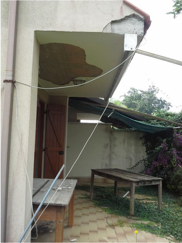
Foto n. 35/37 – Viste del cornicione danneggiato su cui era stata ancorata l'antenna TV
