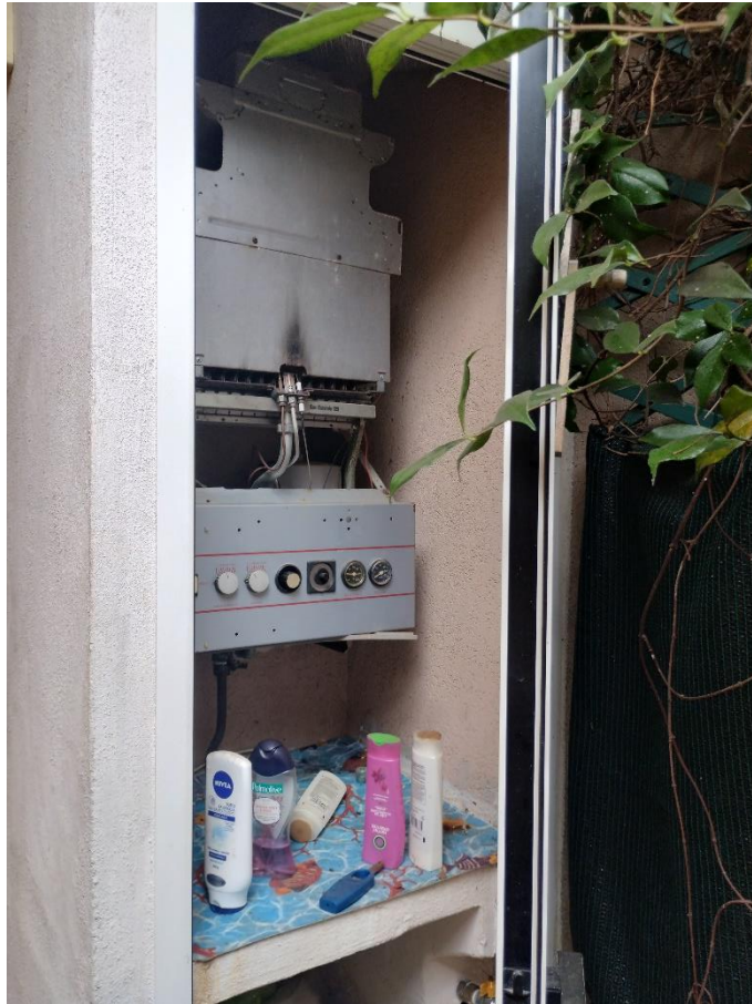
Foto n. 95/96 – Caldaia collocata in un box metallico all'interno del giardino
