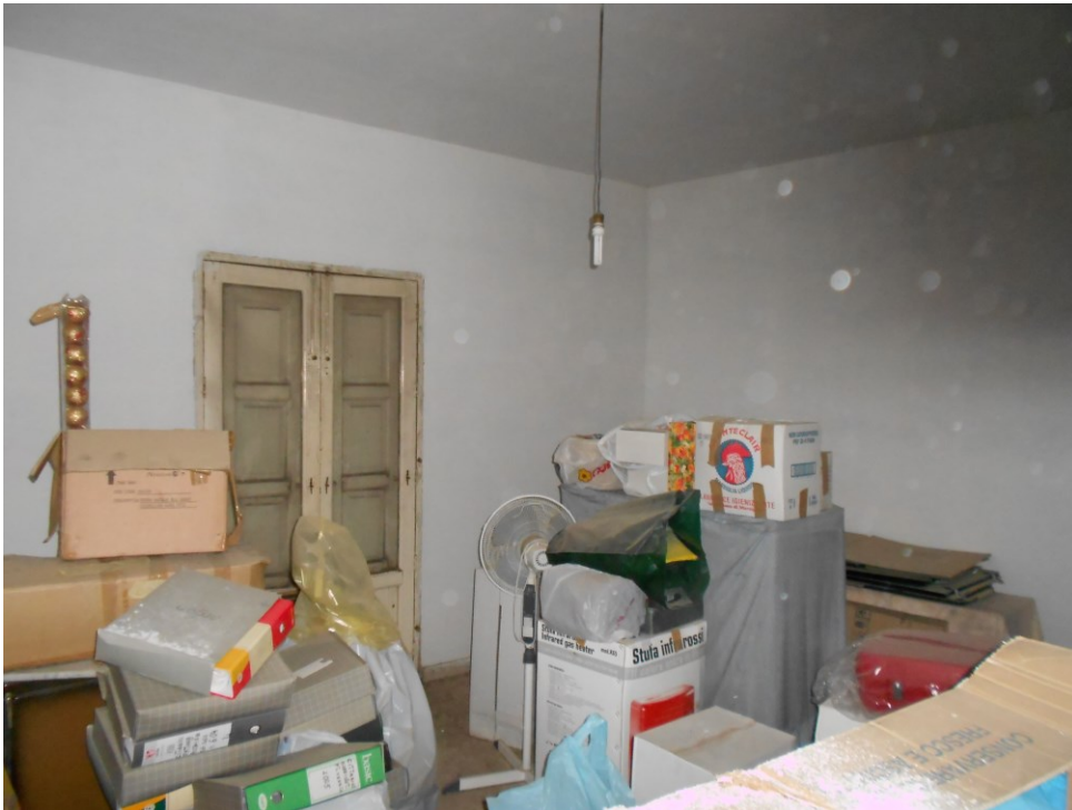
Foto n ° 7 – Vano con balcone sul prospetto lato Nord-Ovest.
