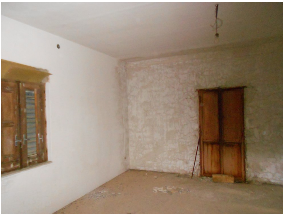
Foto n ° 12 – Vano adiacente a quello di cui alle foto n° 10 e 11, con balcone sul prospetto lato Sud-Est dell'immobile e prospiciente la corte non oggetto di stima.
