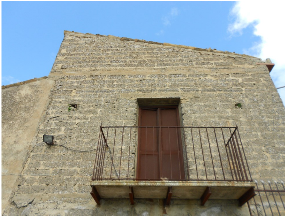
Foto n ° 17 – Porzione del prospetto lato Sud-Est, ripresa dalla corte di cui alla foto n° 16.
