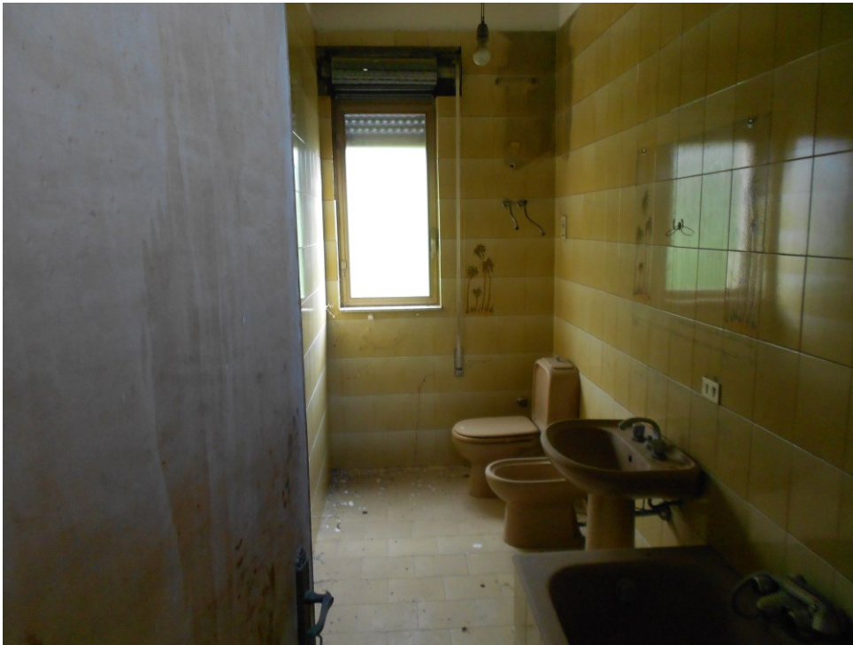
Foto n ° 5 – Locale WC.
