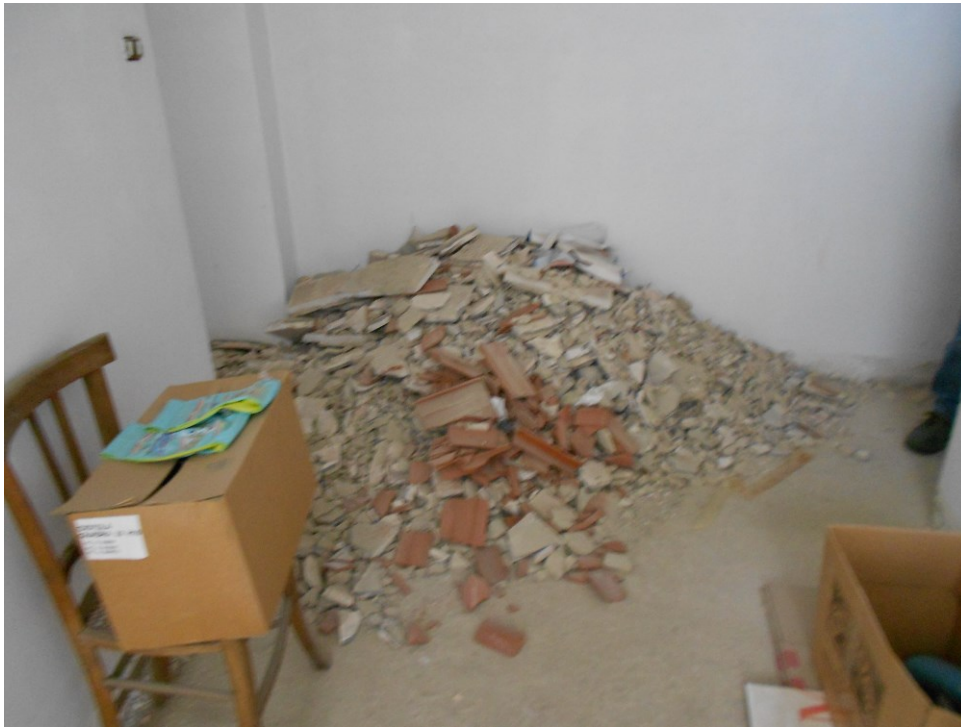
Foto n ° 3 – Vista dell'ingresso dell'unità abitativa.
