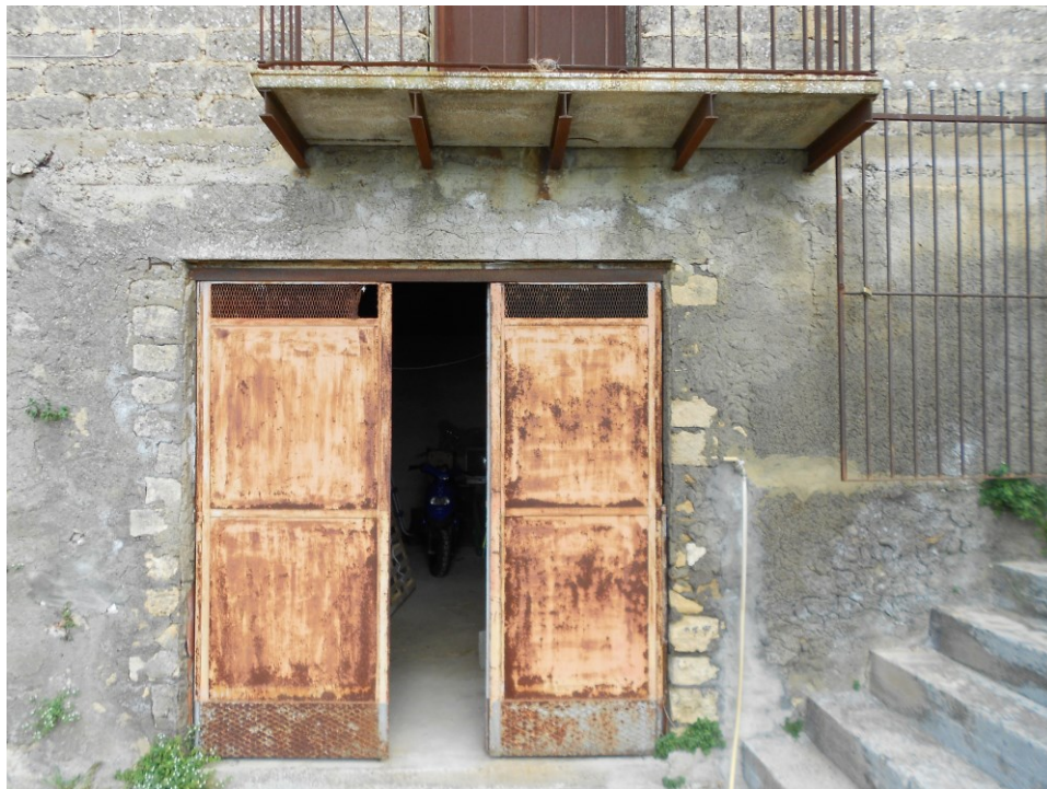
Foto n ° 18 – Idem foto n° 17 – Particolare dell'accesso al locale di sgombero.
