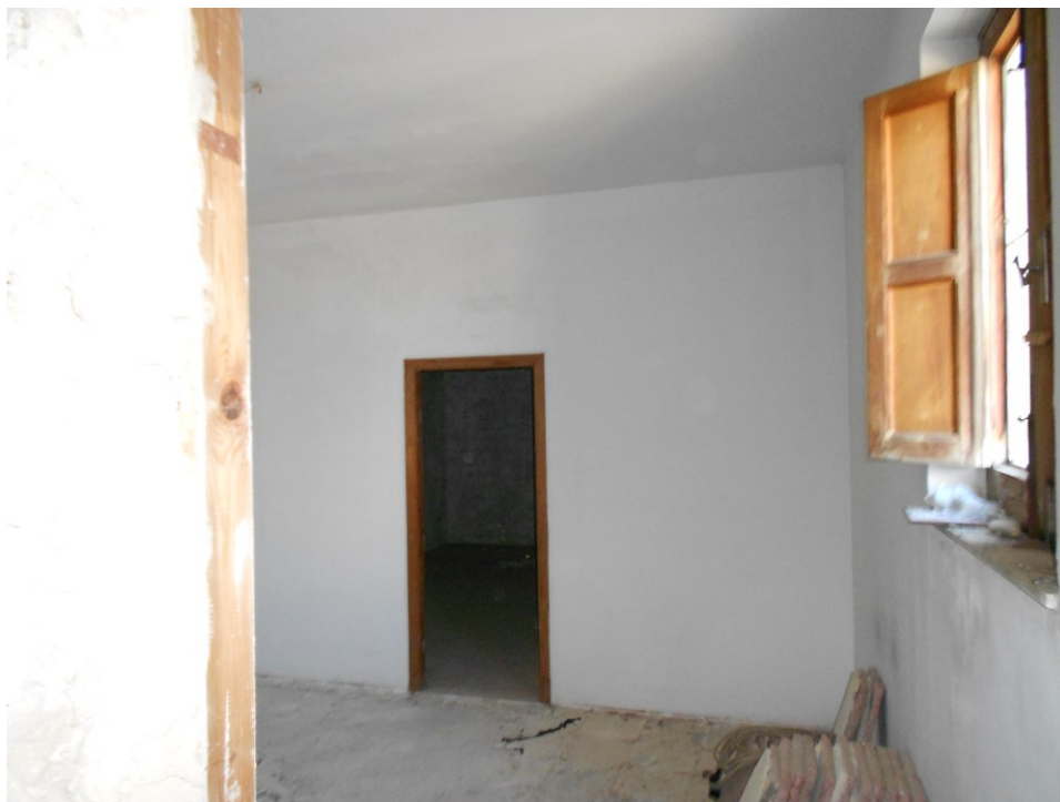
Foto n° 10 – Vano a cui si giunge percorrendo il corridoio di cui alla foto n° 8.
