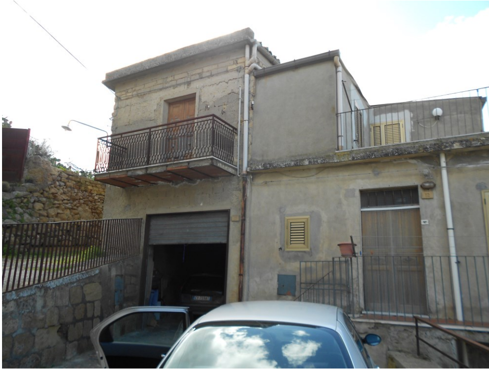
Foto n° 1 – Fabbricato oggetto di consulenza - prospetto lato Nord-Ovest.
