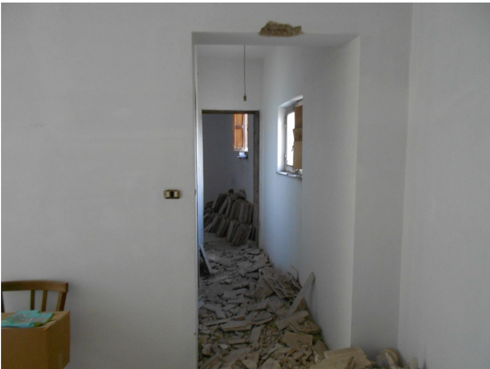
Foto n ° 8 – Corridoio conducente la porzione lato Sud-Est dell'immobile.
