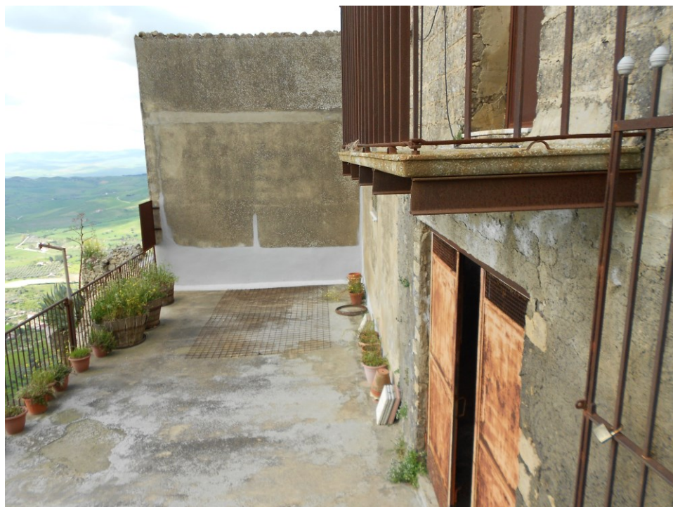
Foto n ° 16 – Corte non oggetto di stima da cui si accede al locale di sgombero di pertinenza e sottostante l'unità abitativa.
