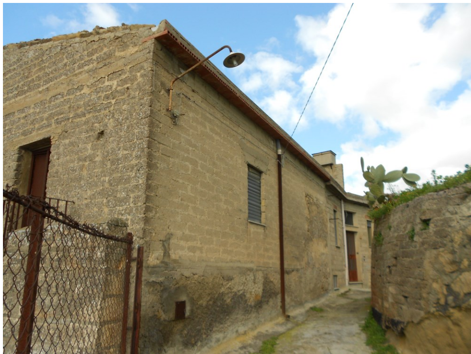
Foto n° 14 – Vista del fabbricato oggetto di stima, ripresa dal lato Sud della via Patané.
