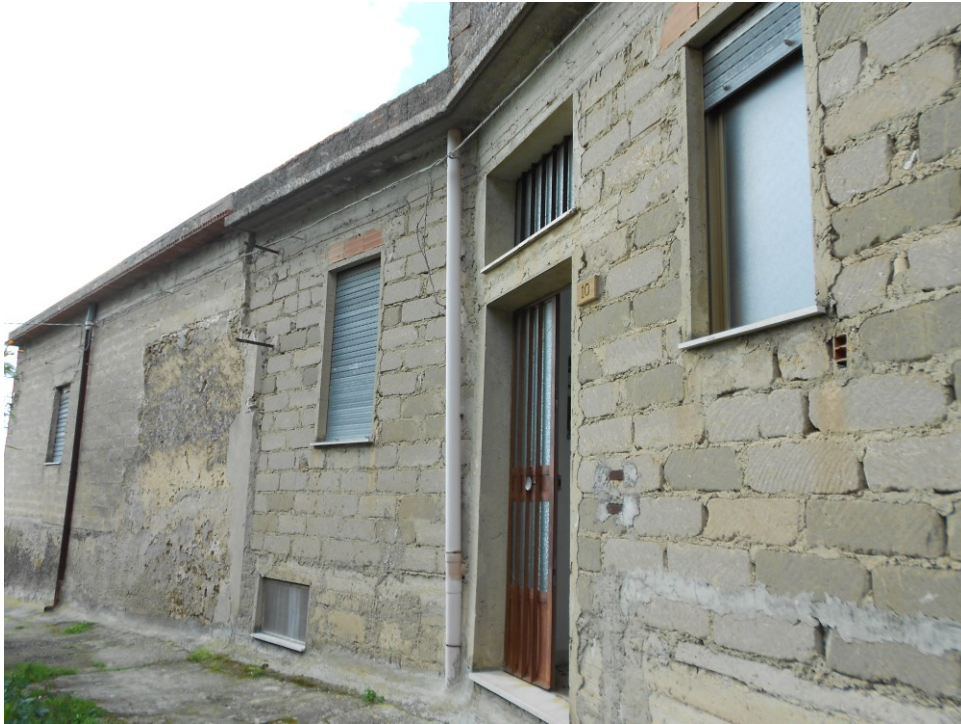
Foto n° 2 – Prospetto lato Nord-Est - accesso dal civico n° 10 della via Patanè.
