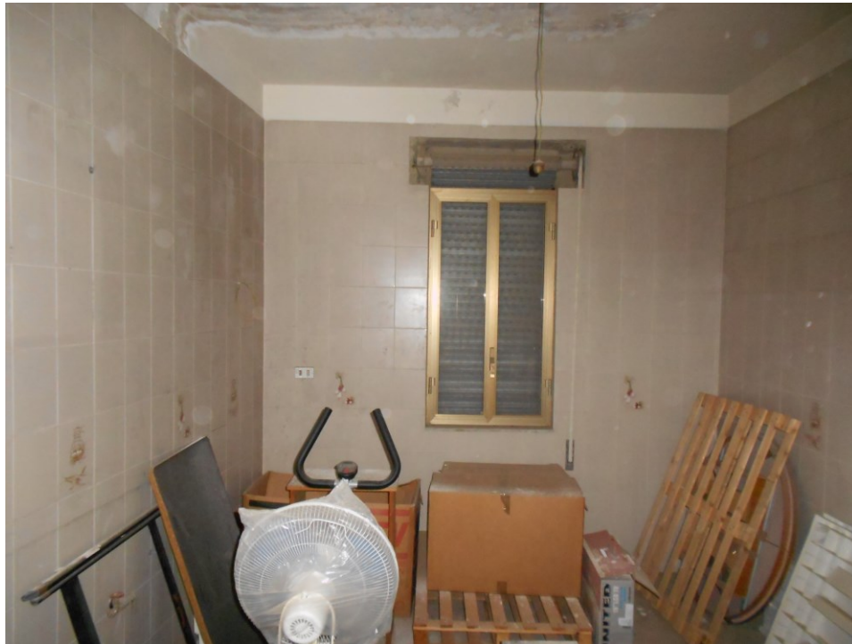
Foto n° 9 – Locale cucina abitabile.
