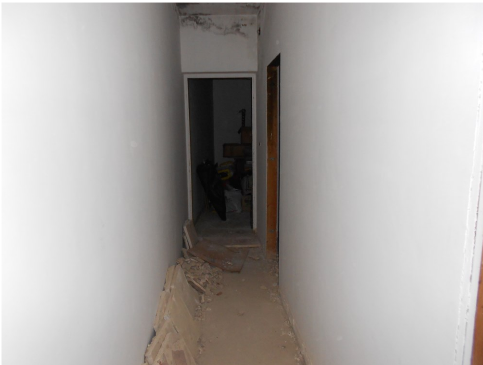
Foto n ° 4 – Corridoio conducente alla porzione lato Nord-Ovest dell'unità abitativa.
