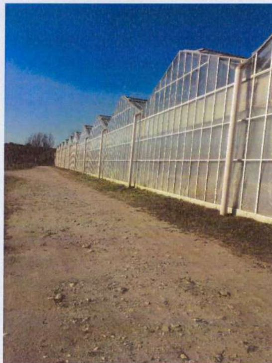
Foto N. 2 – Vista prospettica esterno "prima serra"
