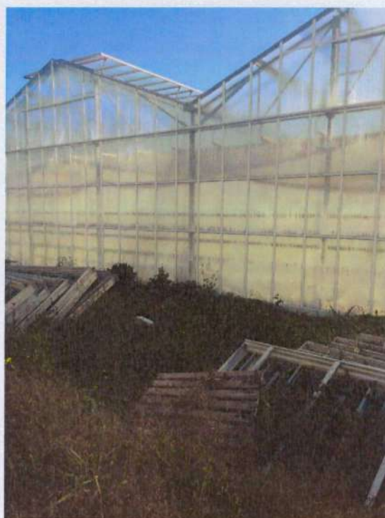
Foto N. 8 – Particolare apertura colmo “prima serra”
