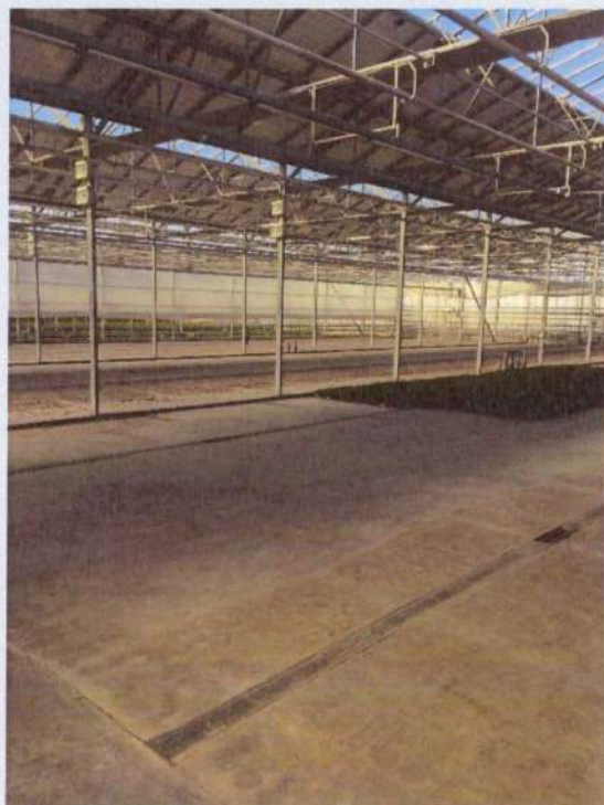
Foto N. 6 – Vista interno “prima serra”
