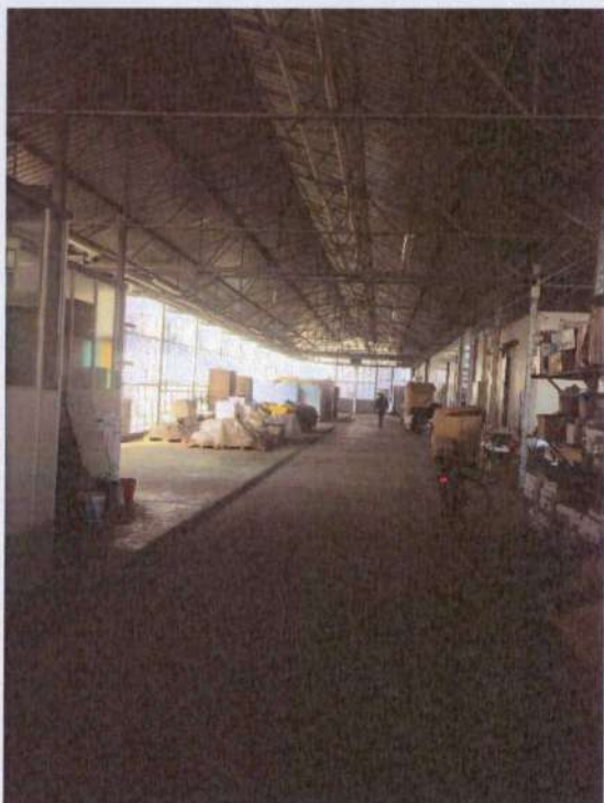
Foto N. 5 – Vista interno avanserra
