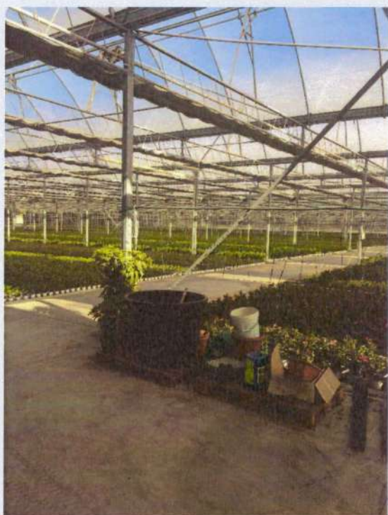
Foto N. 7 – Vista interno “seconda serra”
