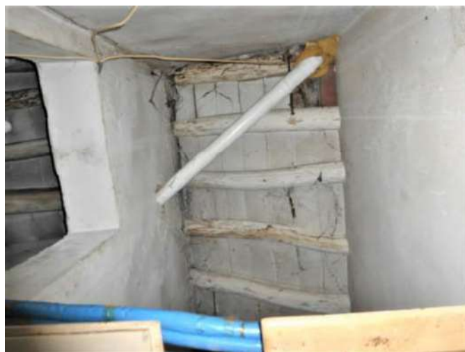
dettagli intradossso copertura delle porzioni controsoffittate
