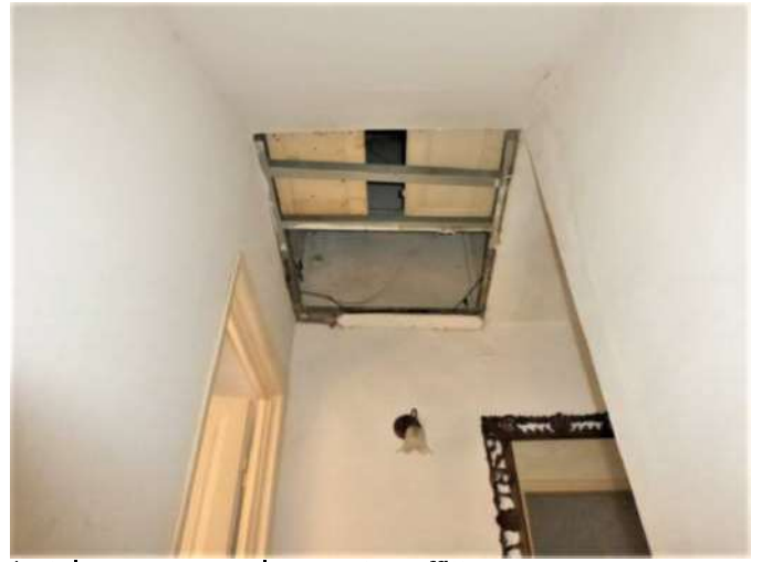
botola accesso palco morto soffitta
