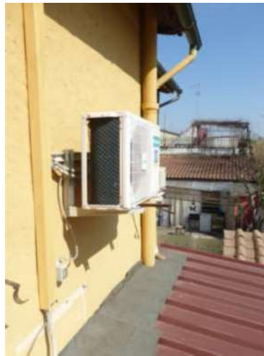
dettaglio facciata tergale
