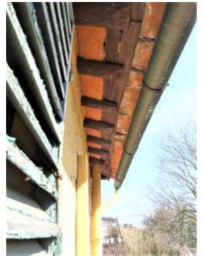
dettaglio facciata tergale
