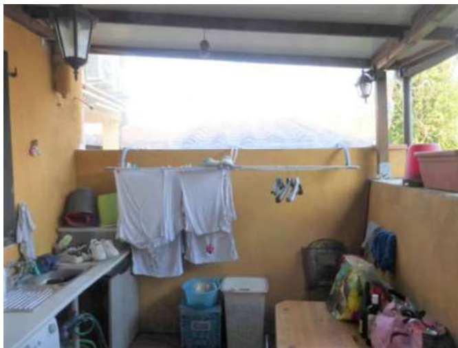
locale 5 - corte illegittimamente coperta
