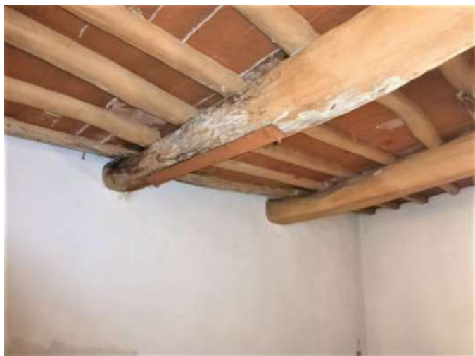
dettaglio intradossso copertura locale 2
