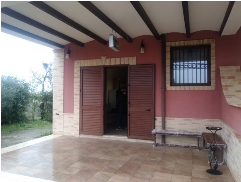
Fotografia J.8 - Portico su prospetto ovest.
