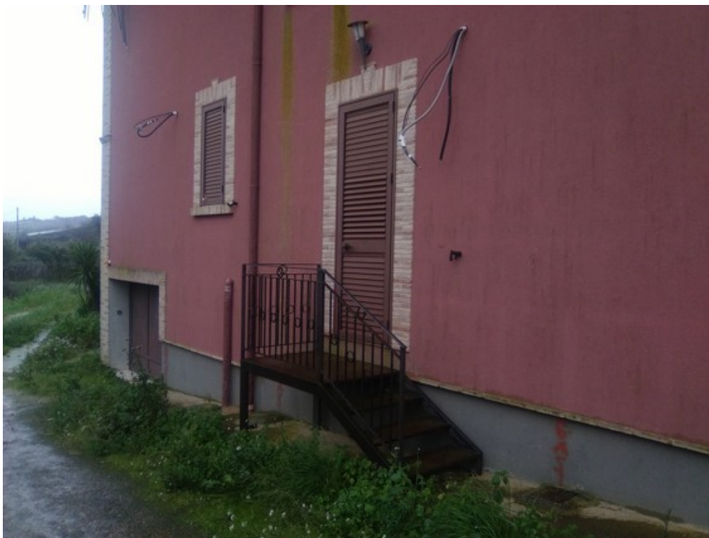
Fotografia J.10 - Accesso secondario su corte comune.
