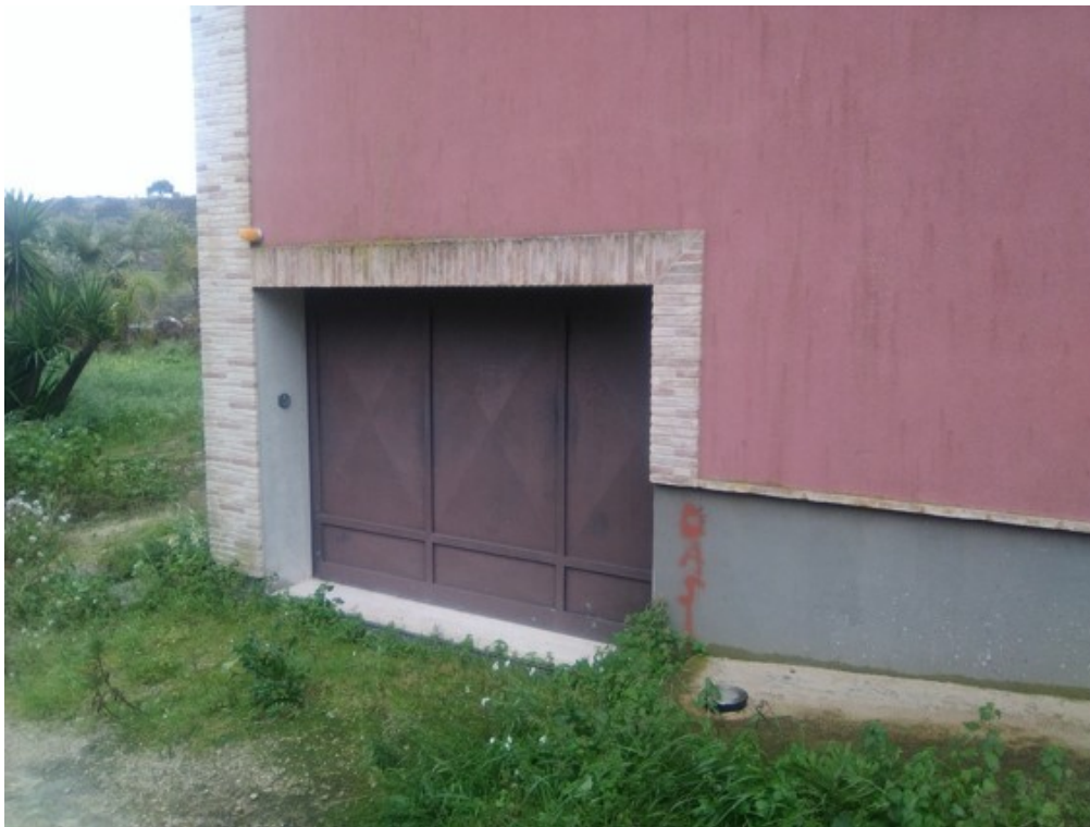
Fotografia J.1 - Accesso su prospetto nord.
