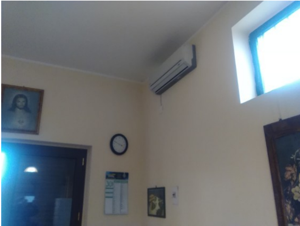
Fotografia J.11 - Ripresa interna in cui si nota la presenza di impinato di climatizzazione, la porta di accesso principale che da sul portico posto a ovest e una luce posta a nord.
