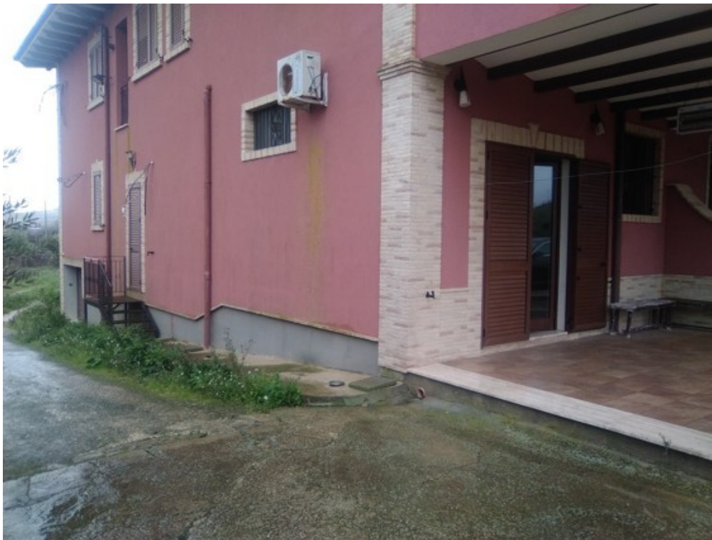
Fotografia J.9 - Ripresa prospetto nord-est.
