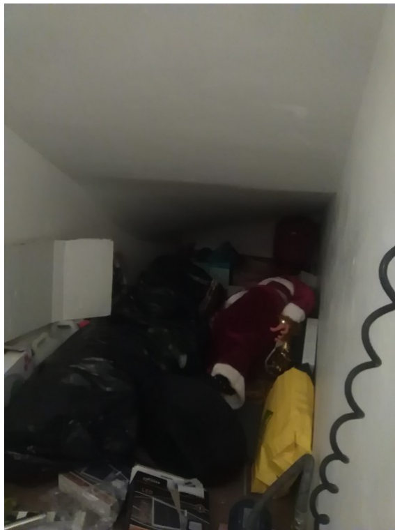
Fotografia J.14 - Particolare di un vano con accesso dal locale di cui al sub 5 ma rientrante nel confinante sub 6. Nel locale in questione è presente una botola di ispezione di una vasca idrica posta sotto il confinante sub 6.
