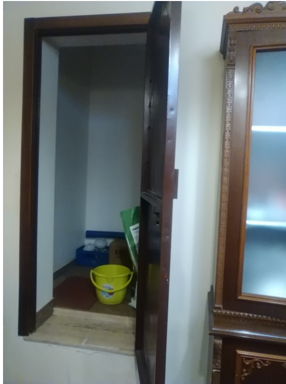
Fotografia J.13 - Accesso ad un locale rientrante nel confinante sub 6, nel quale non vi è collegamento diretto, ma solo tramite il sub 5 in questione.
