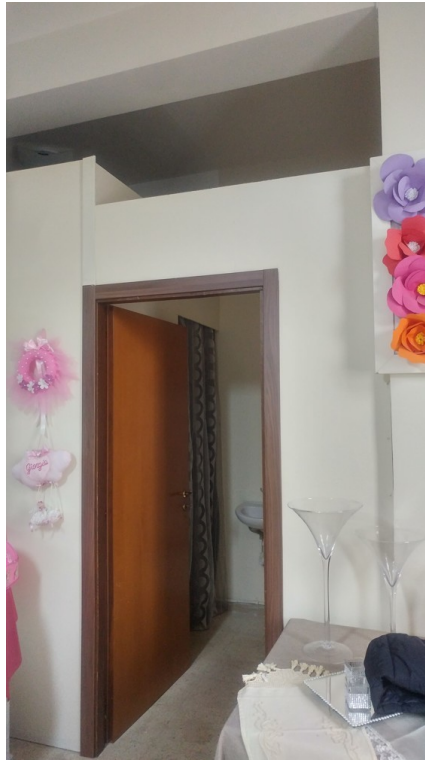
Fotografia I.5 - Ripresa dell'interno locale al civico n. 21 via Portella delle ginestre. Si nota la presenza di un muro misto laltero cemento e legno, con porta che separa il locale con altro ambiente destinato a ripostiglio ricavato da anza del locale che fa angolo con il locale dei servizi igienici.
