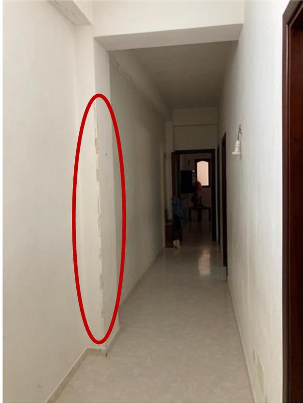
**Figura 15.** Vista del corridoio principale (foto 2), si nota distacco di intonaco sul pilastro
