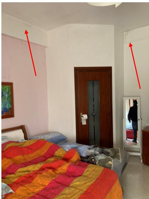
**Figura 24.** Vista della camera da letto: si noti uno dei due ripostigli realizzati nella stanza (foto 1); si notano macchie di umidità sulle pareti
