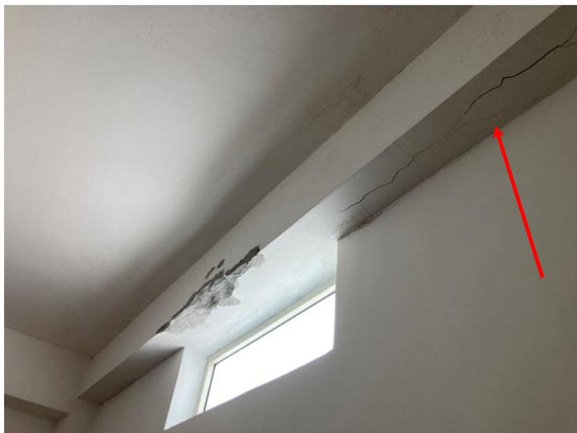
**Figura 19.** Particolare della finestra nel corridoio principale; si nota lesione sulla trave
