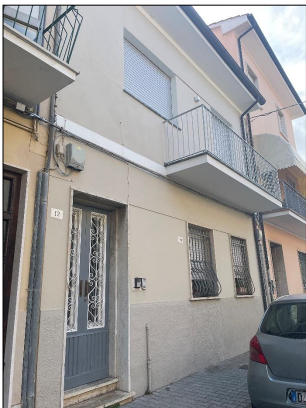
Facciata del fabbricato
