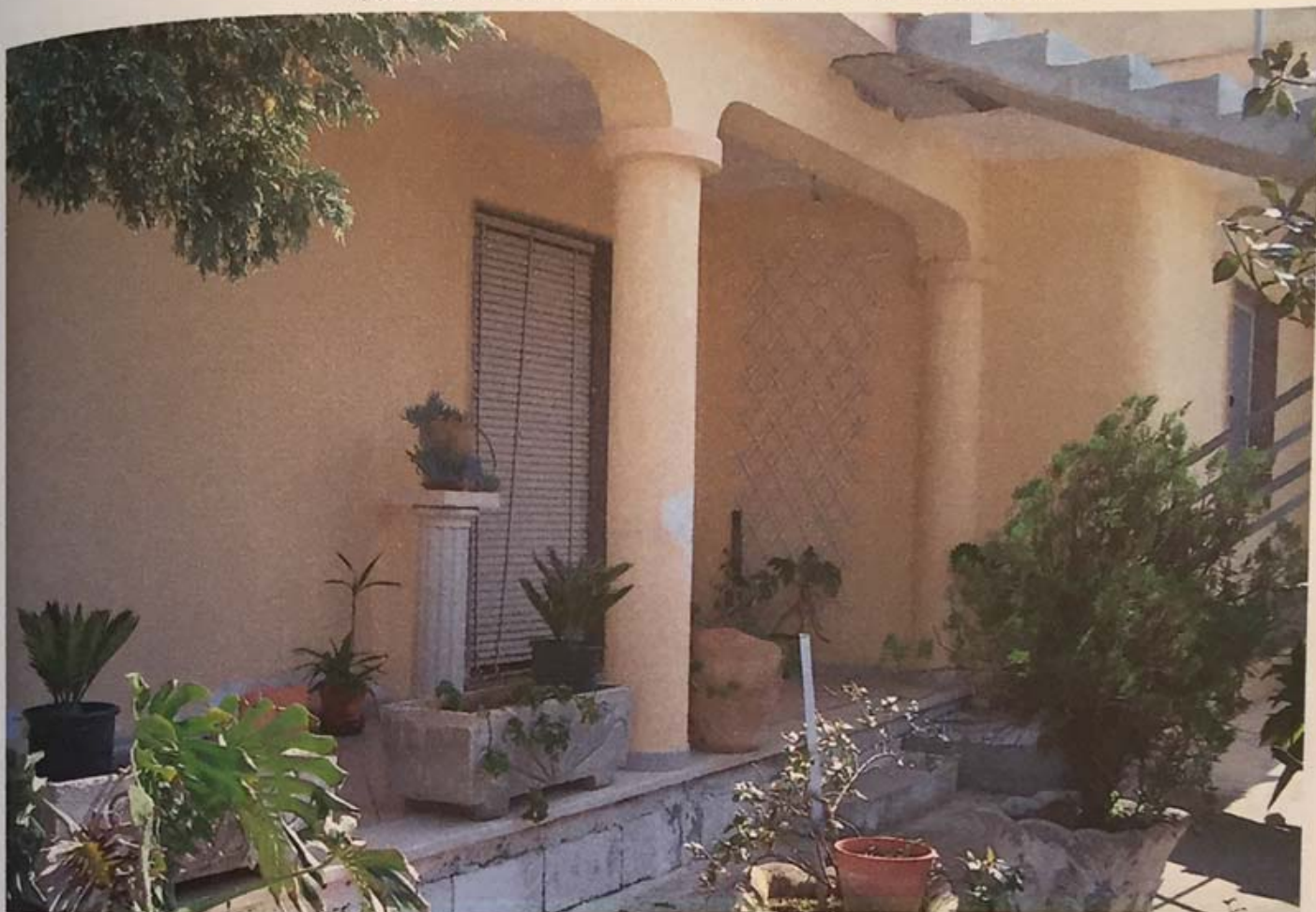
foto n.2: Vista esterna lotto B via Ponchielli
