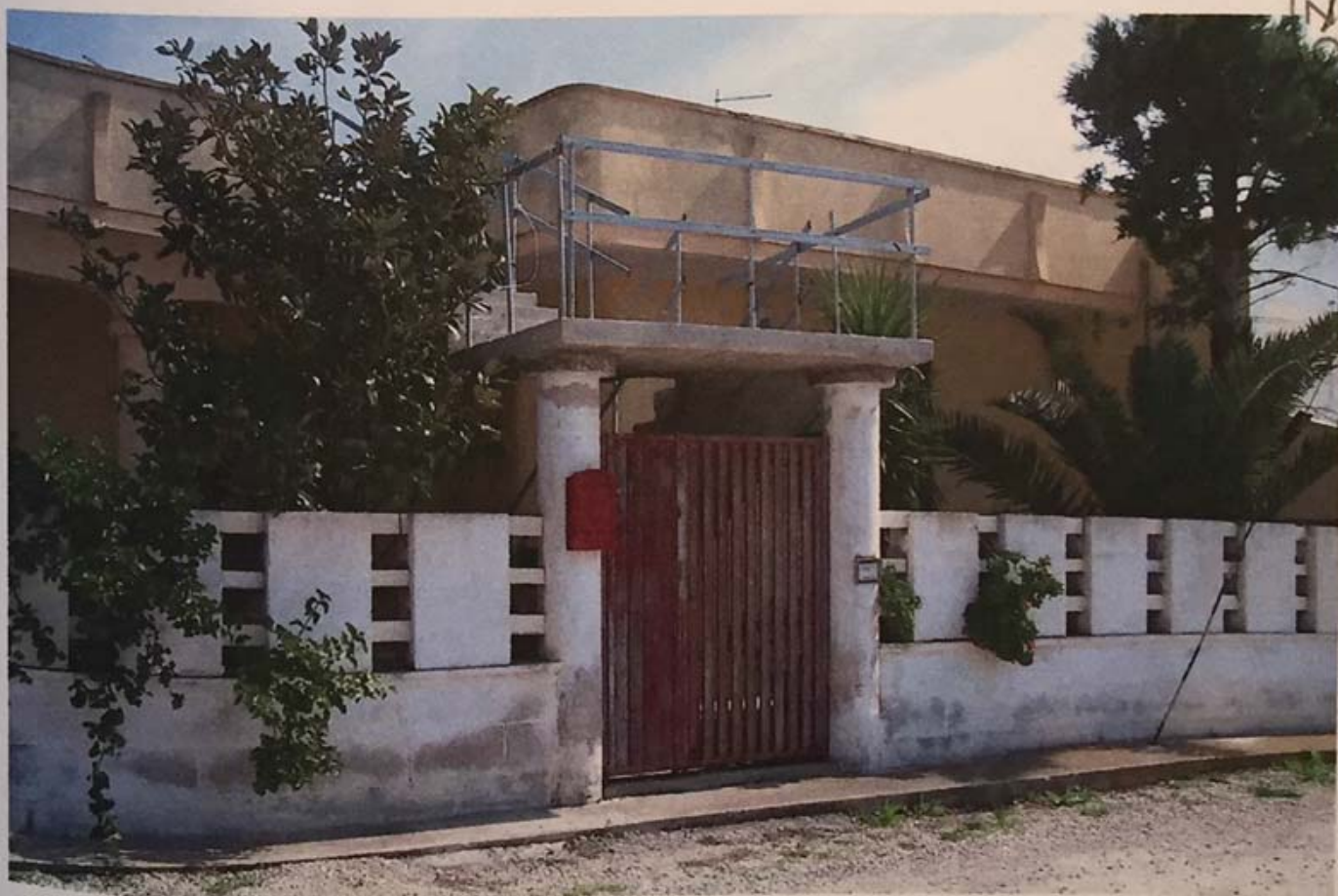
foto n.1: Vista esterna lotto B via Ponchielli
