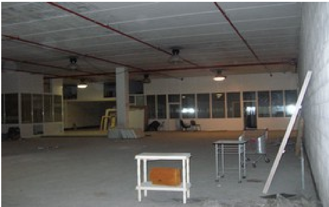
Foto F/8680 Interno lato sud con vista compartimentazioni uso ufficio/ripostiglio
