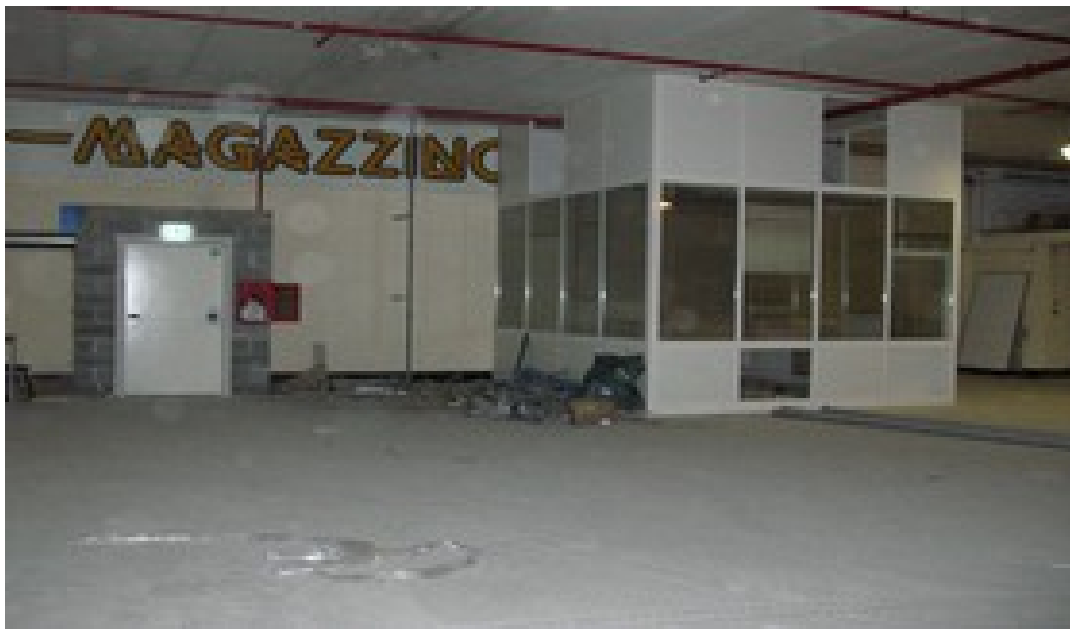
Foto H/8681 Compartimentazione lato sud e uscita di sicurezza
