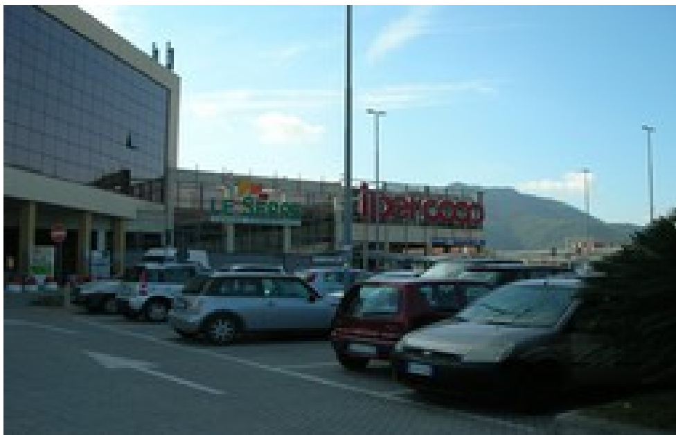
Foto A-B/8495-96 Complesso immobiliare “Albenga 2000” civ.39 Regione Bagnoli Albenga
