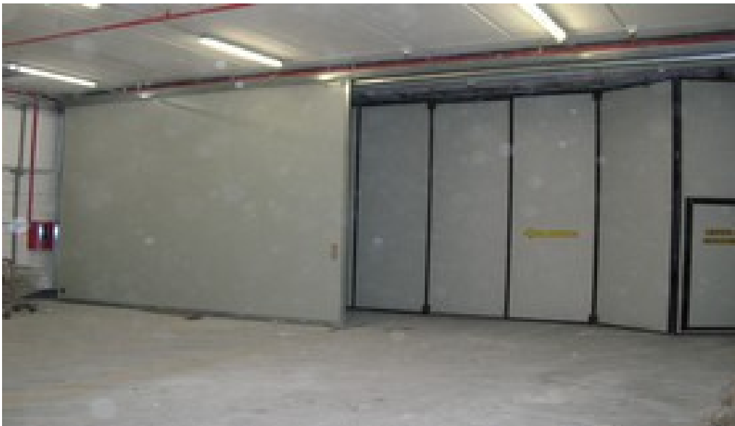
Foto D/8429 Portone interno a prova di fumo ed esterno a libro
