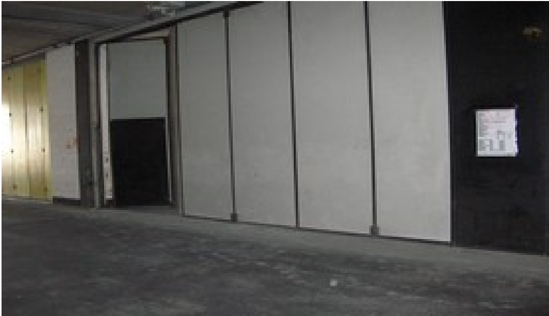
Foto C/8492 Ingresso da corsia condominiale pedonale e carraio con portone a libro
