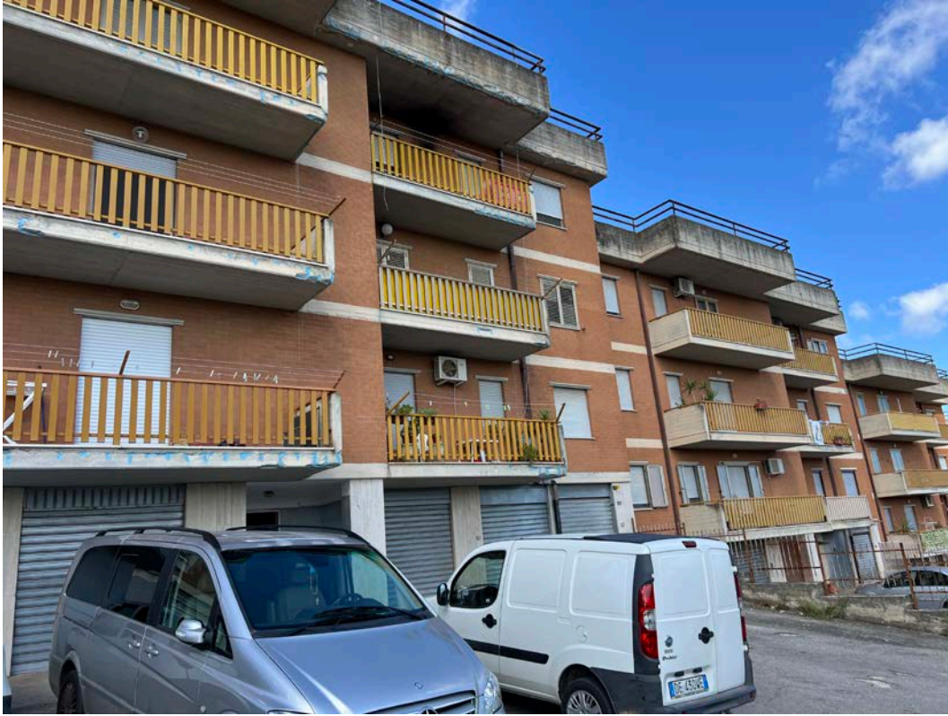
FOTO n. 12 – Prospetto posteriore edificio –
