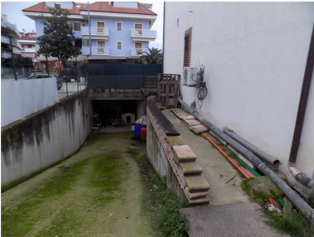
Rampa di Accesso al piano interrato – visibile la chiusura dello spazio di manovra sotto e l'aiuola da rinterrare (lato ovest)
