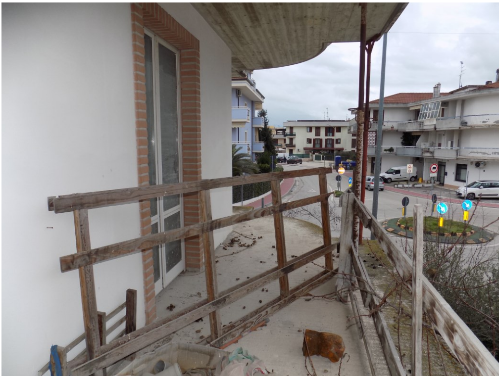
Piano Primo – stato attuale - balconi
