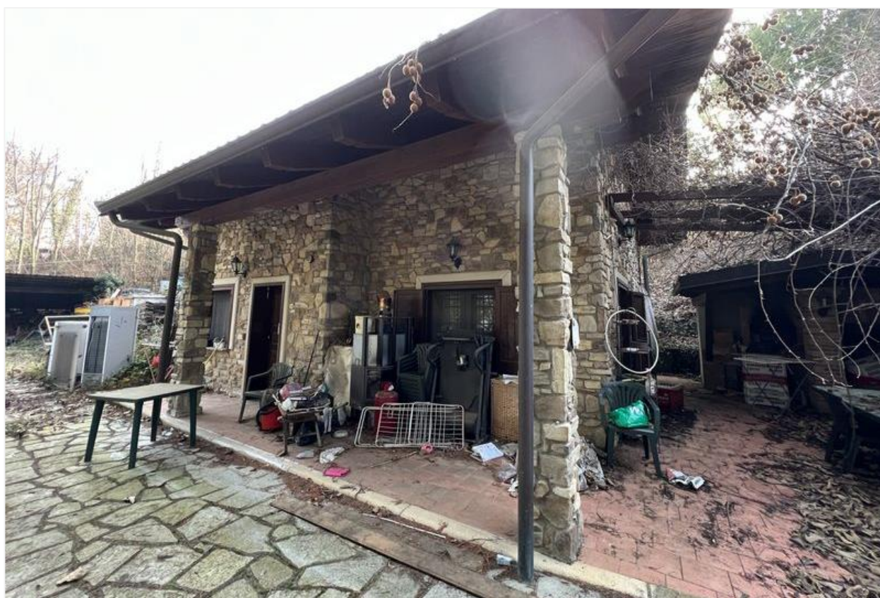
Vista delle facciate lato nord (rivestita in materiale lapideo) ed est (rivestita in perlinato di legno)
