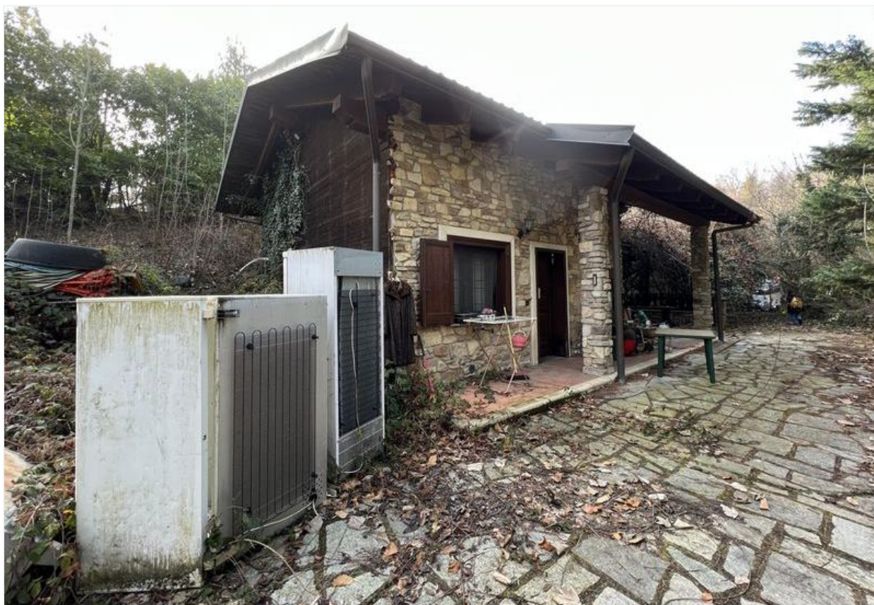
Vista delle facciate lato nord (rivestita in materiale lapideo) ed est (rivestita in perlinato di legno)
