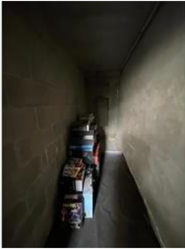
cantina - porzione parte dx
