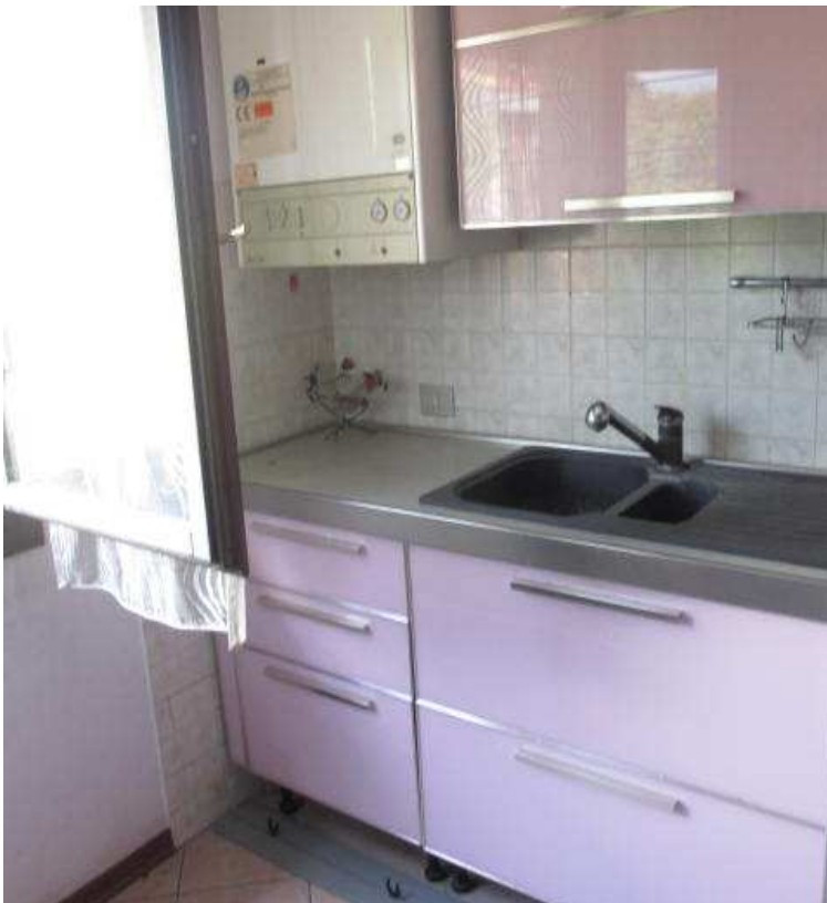
83.21 ANGOLO COTTURA – CALDAIA TERMICA
