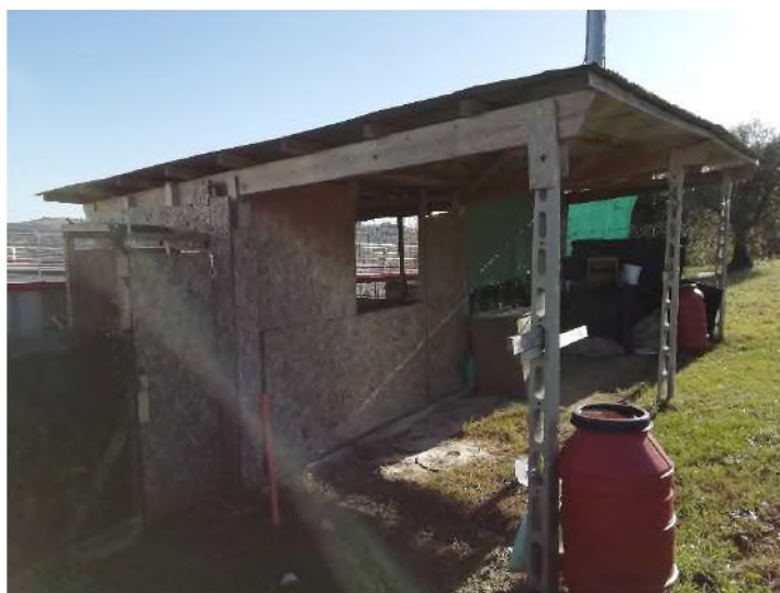
Tettoia (da demolire)
