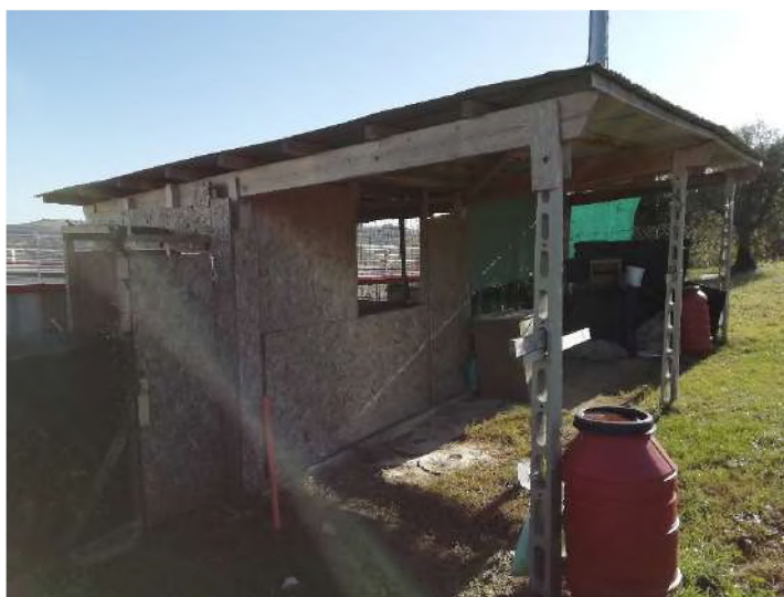
Tettoia (da demolire)
