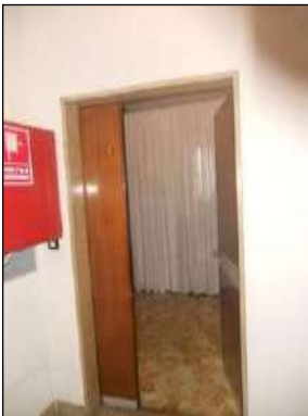
Entrata all'U.I. da vano scala
