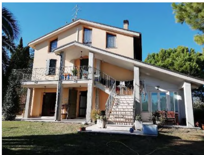
Prospetto Sud-Est: porticato, scala esterna, loggia e balcone
