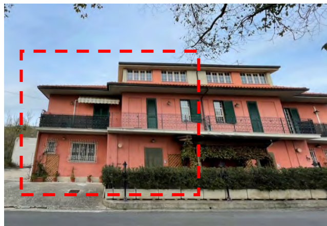
fig. 2 Porzione abitativa lotto 2
