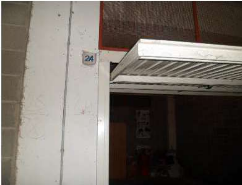
Foto n°4-Garage sub 66 al n° 24
