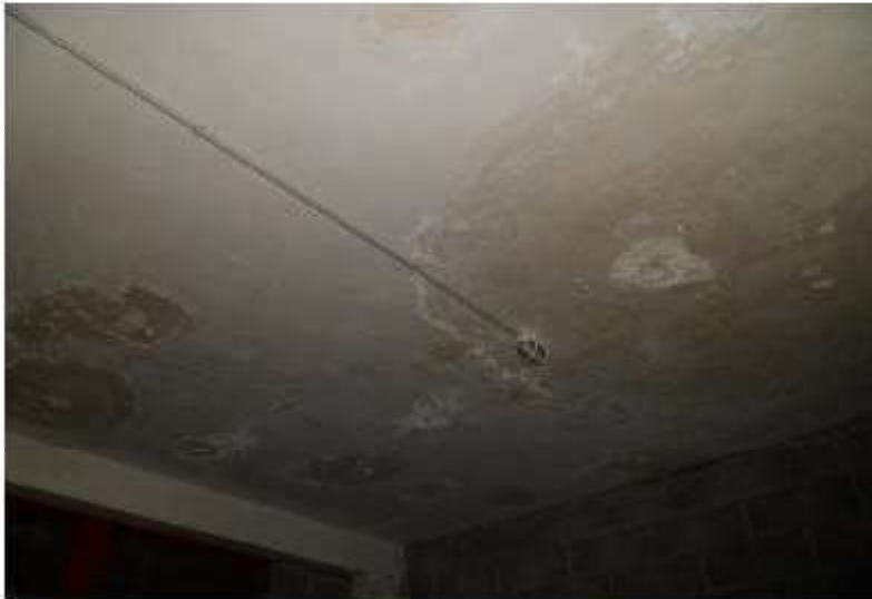
Foto n°6--Garage sub 66 stato di fatto del soffitto
