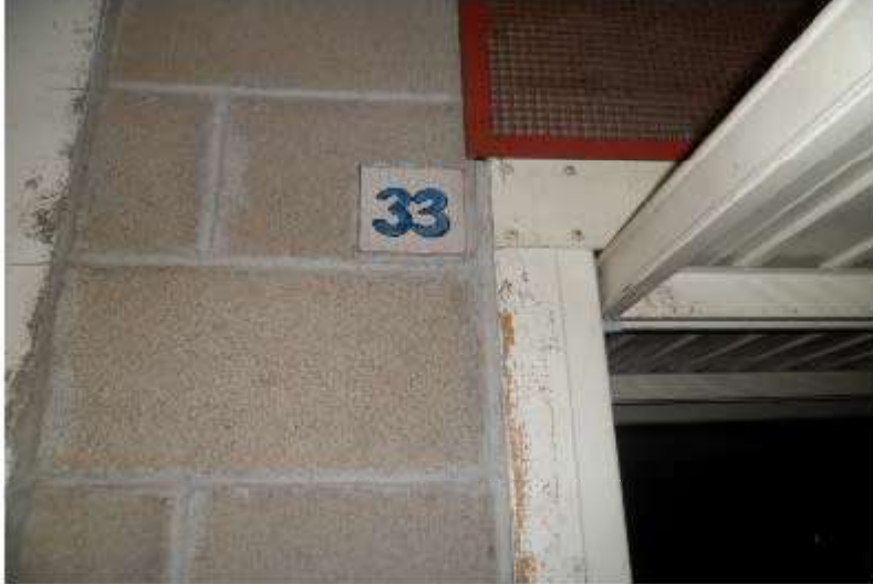
Foto n°7- Garage Sub 75 al n°33
