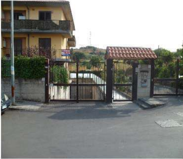
Foto n°1-Ingresso ai Garages da via Tomasi di Lampedusa n°45
