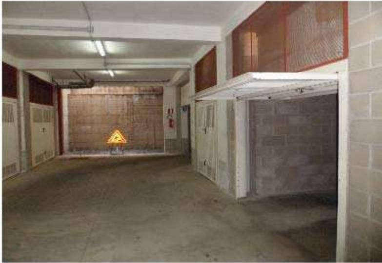
Foto n°3-Corridoio di accesso ai garages
