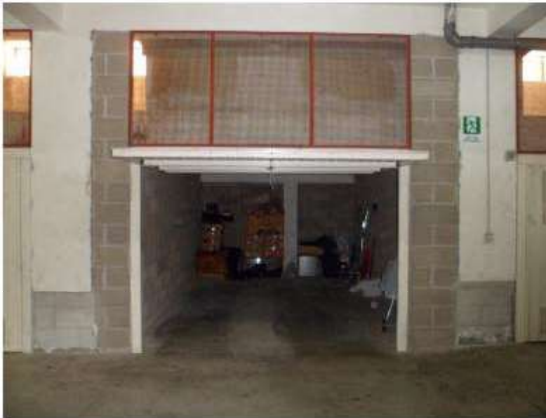
Foto n°8–Garage Sub 75 al n°33 rifiniture interne, pareti con mattoni a vista e pavimentazione in cemento liscio.
