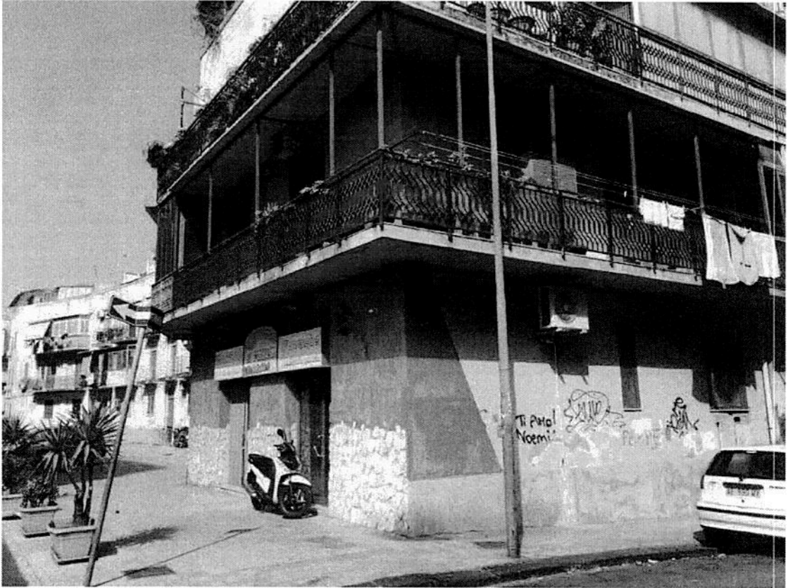
FOTO 3: Prospetto del fabbricato su via Liguria
