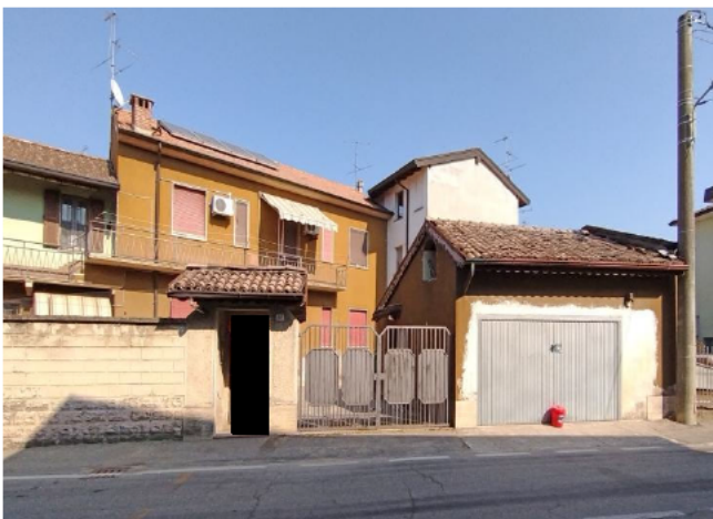
Ingressi pedonale e carrabili (Sub.5) lungo Via Roma
