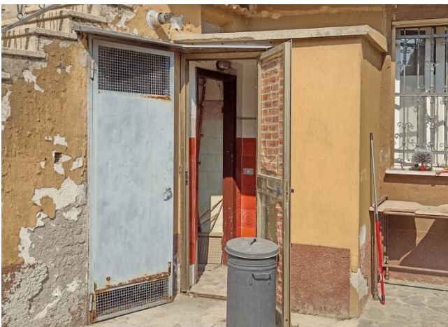
Sub.9 - Disimpegno; Sub.2 - Ingresso e WC sulla sinistra
