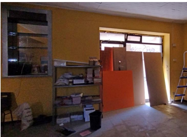
Dettaglio vetrina e ingresso da Via Roma, civico 54
