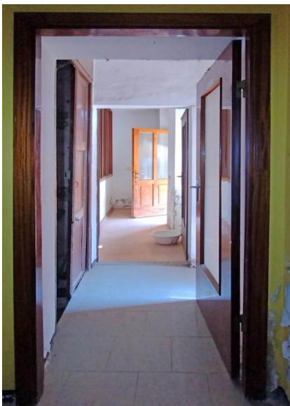
Corridoio, ingressi dal cortile e al PI
