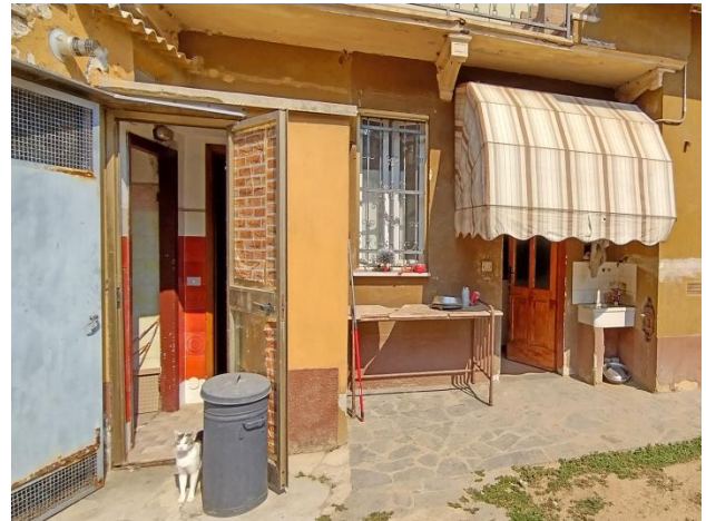
Sub.2/9 - Ingressi interno cortile (da civico 56)
