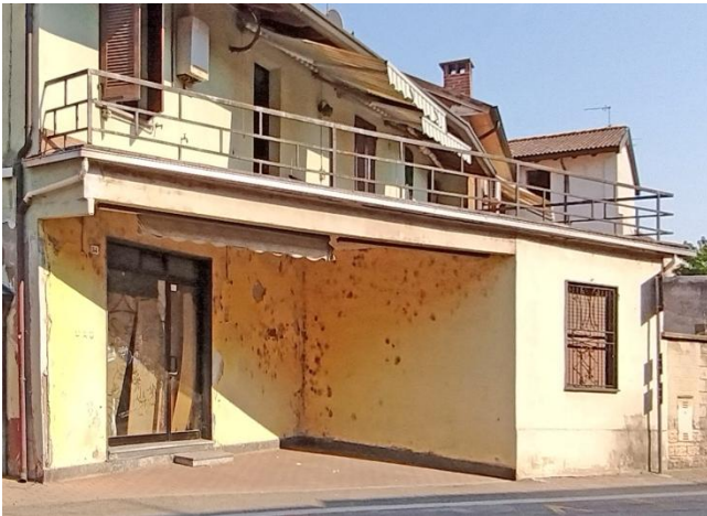
Sub.2 - Portico ingresso Via Roma, civico 54
