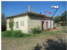
Foto 5 - Veduta porzione fabbricato Sub. 1
