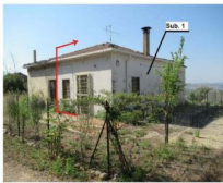
Foto 6 - Veduta porzione fabbricato Sub. 1
