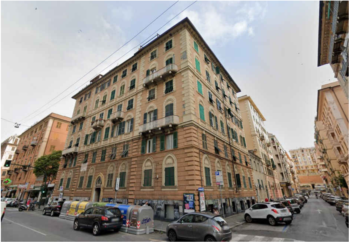
foto n.2- Edificio civ. 10 di via P. Giacometti
