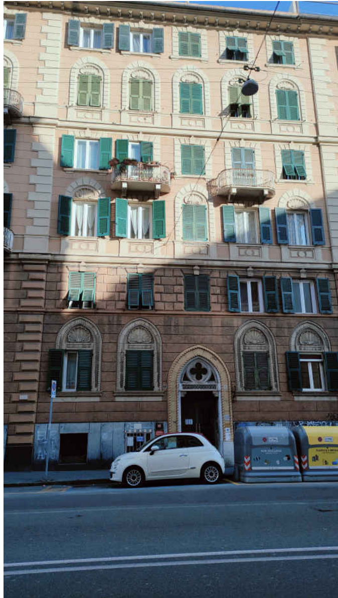
foto n.3- Edificio civ. 10 di via P. Giacometti
