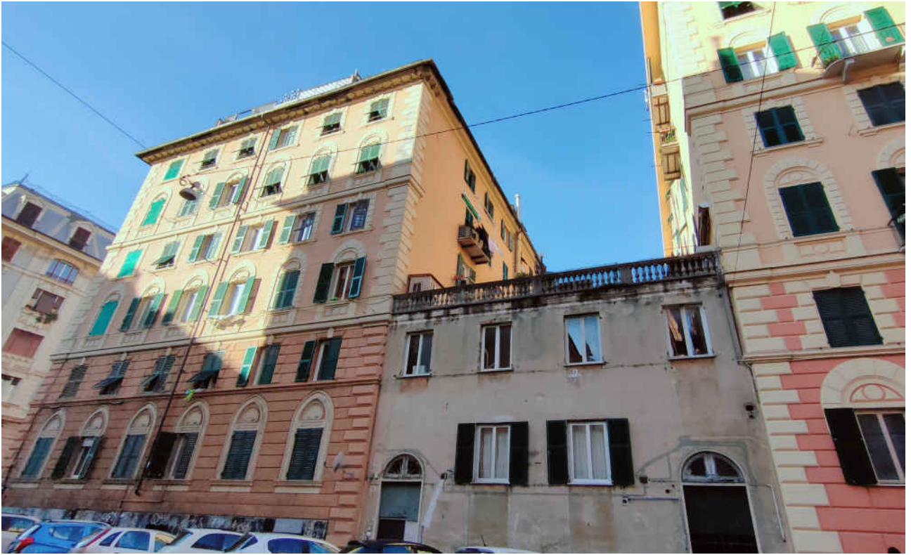
foto n.6- Edificio civ. 10 di via P. Giacometti. Facciata su Via M. Novaro.
