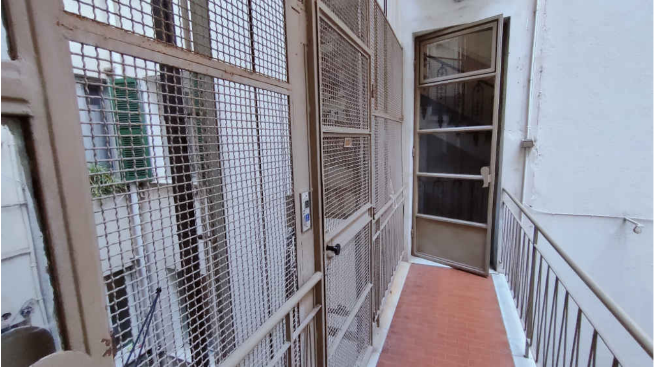
foto n.12- Ascensore che sbarca su passerella posta al centro del cavedio condominiale che serve i due vani scala
