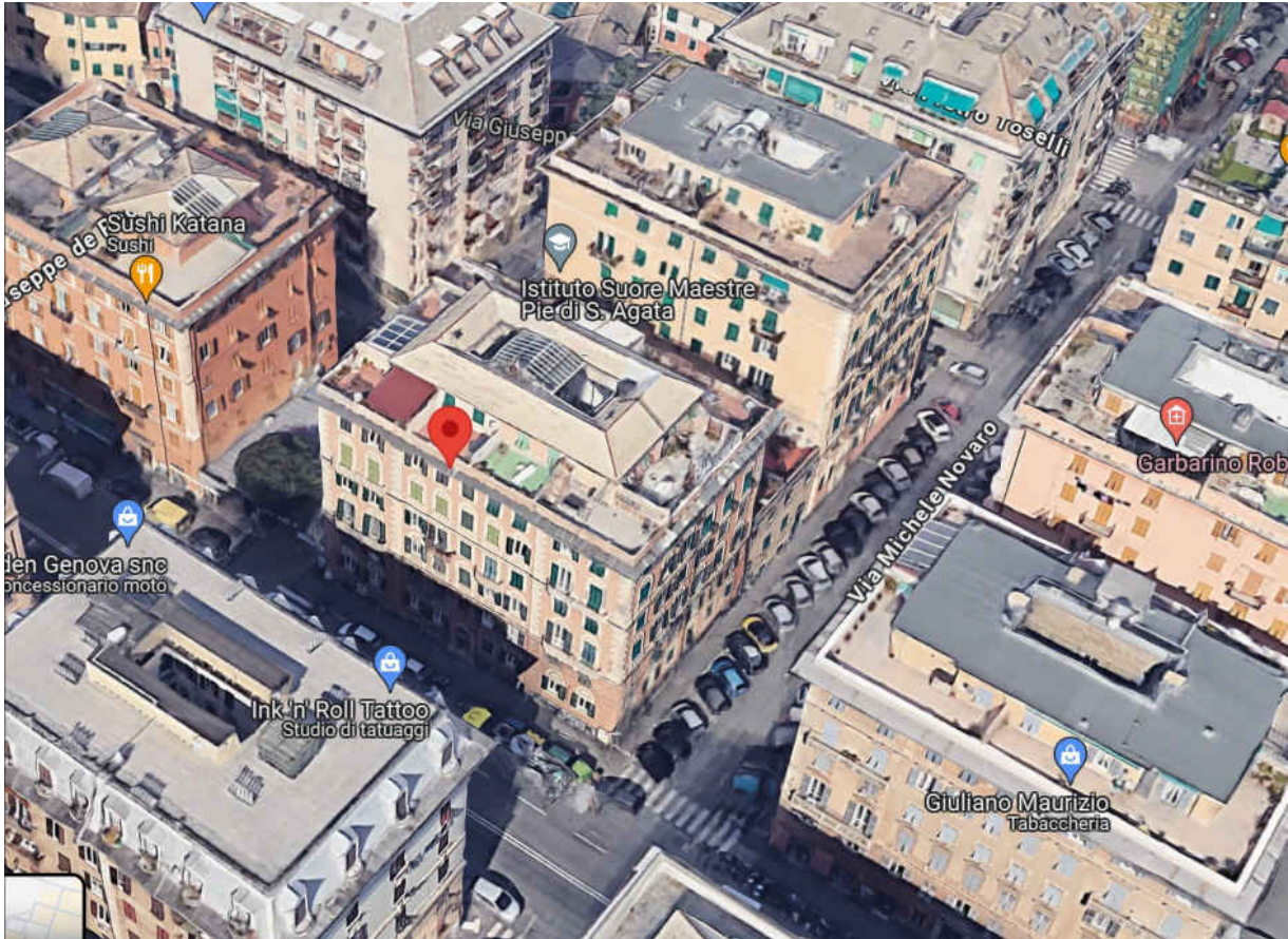
foto n.1- Immagine aerea. In evidenza il civ. 10 di via P. Giacometti
