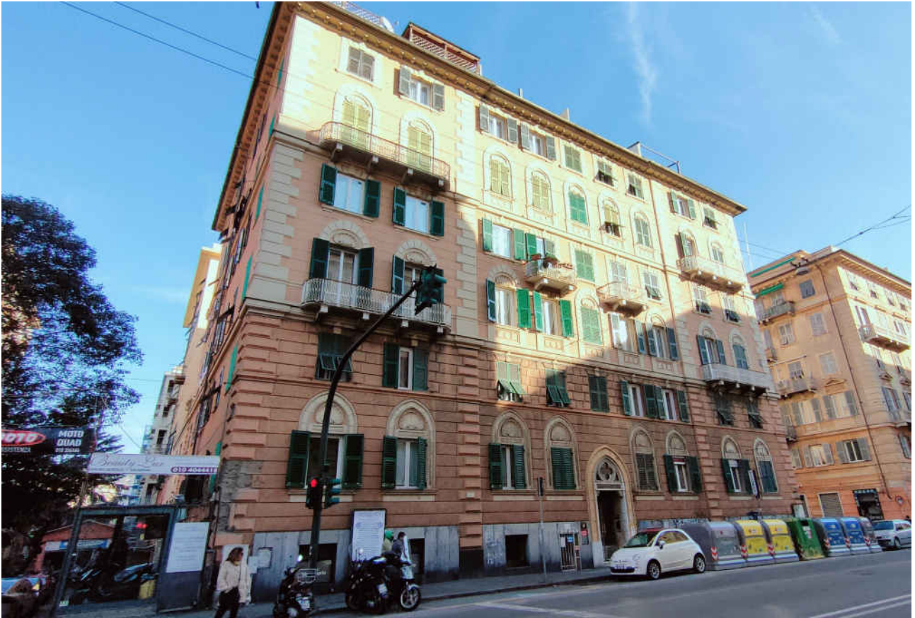
foto n.4- Edificio civ. 10 di via P. Giacometti
