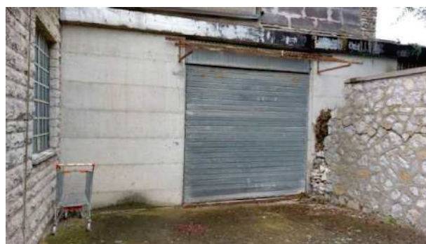
foto nr.02: vista ingresso rimessa-garage
