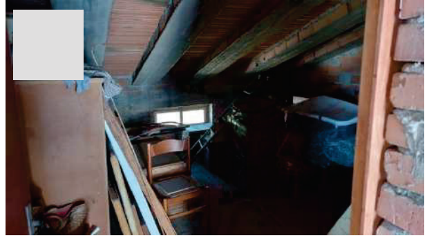
foto nr.62: vista interna soffitta
