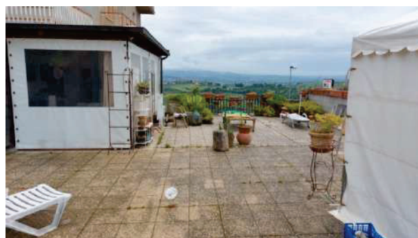
foto nr.56: vista esterna lastrico solare
