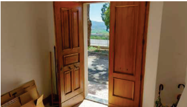
foto nr.07: vista portone ingresso condominio
