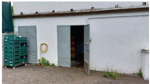
foto nr.66: vista esterna locale tecnico
