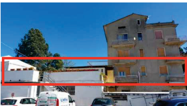
foto nr.03: vista ovest (particolare lastrico)
