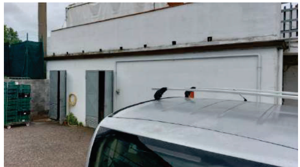
foto nr.68: vista esterna locale tecnico
