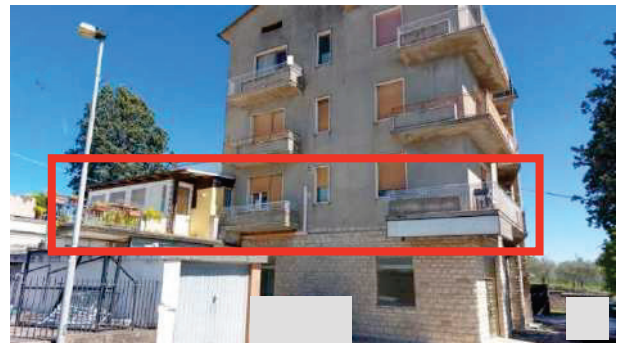
foto nr.02: vista esterni lato ovest
