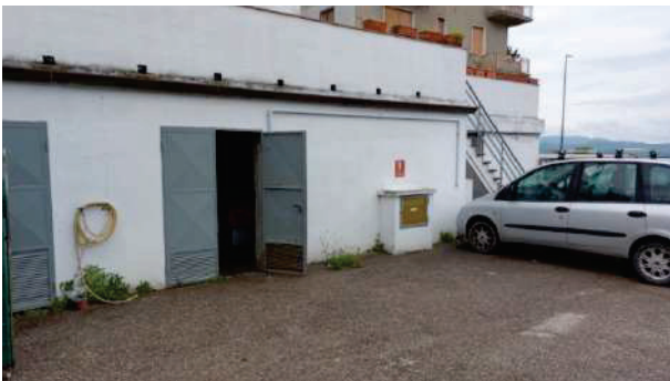
foto nr.67: vista esterna locale tecnico
