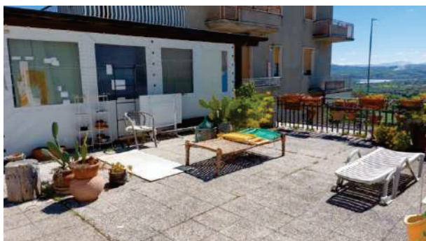
foto nr.59: vista esterna lastrico solare
