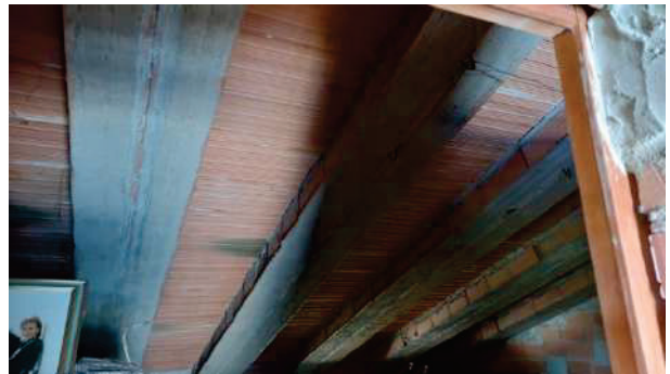
foto nr.64: particolare copertura soffitta
