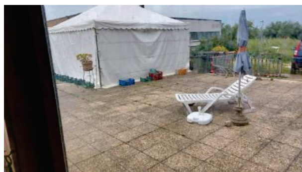
foto nr.58: vista esterna lastrico solare
