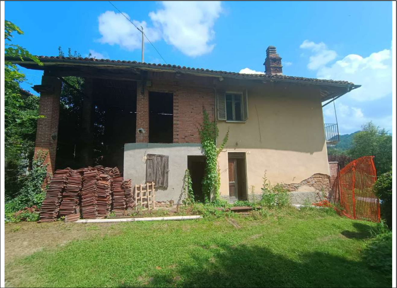
Foto 3. Prospetto ovest della costruzione
