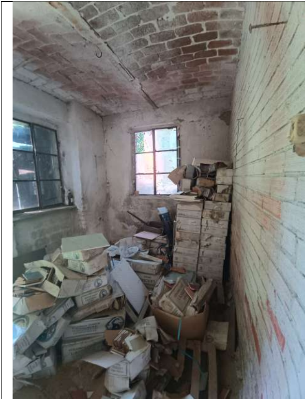
Foto 24. Vista verso sgombero PT (parte unità sub 3 lato ovest)
