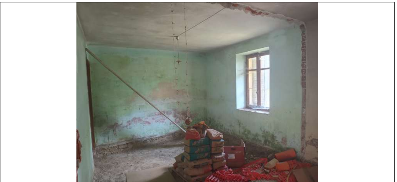
Foto 12. Vista del piano terreno fg 22 part 236 sub 2 verso est
