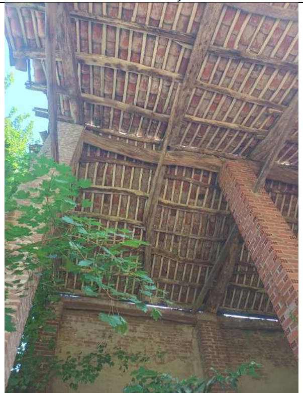
Foto 27. Vista della copertura a vista su sub 3
