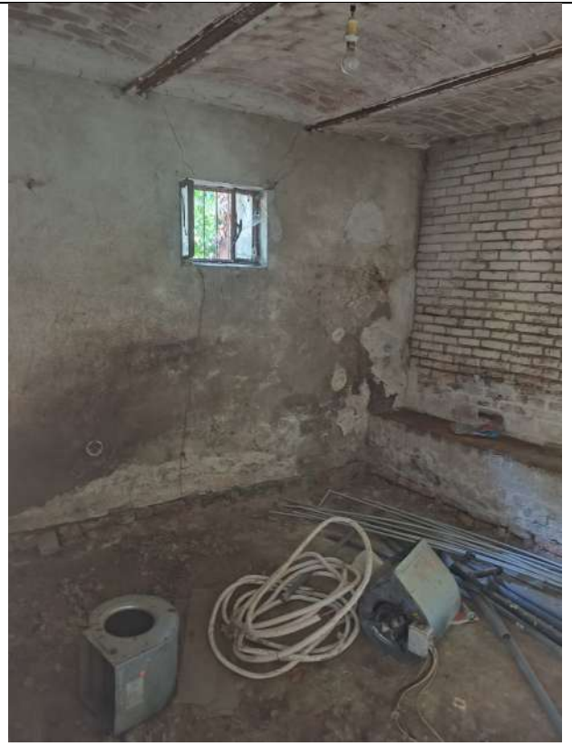
Foto 25. Vista verso sgombero PT (parte unità sub 3 lato est)
