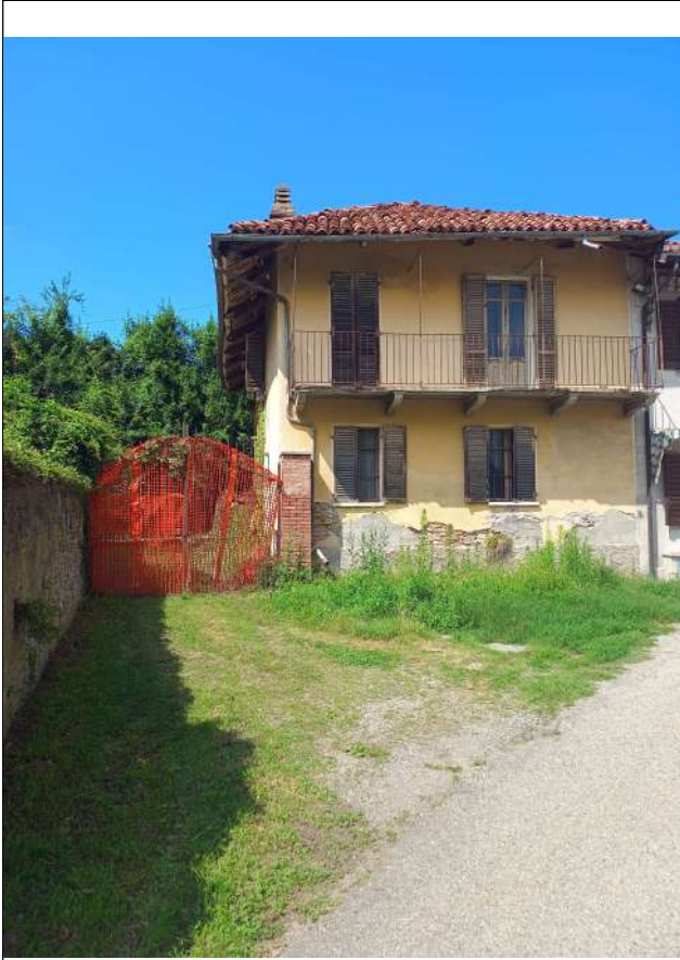
Foto 5. Particolare prospetto sud verso la via
