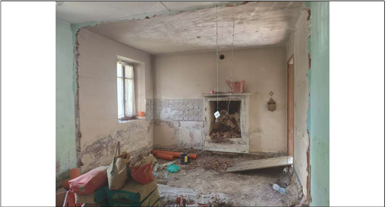
Foto 13. Vista del piano terreno fg 22 part 236 sub 2 verso ovest
