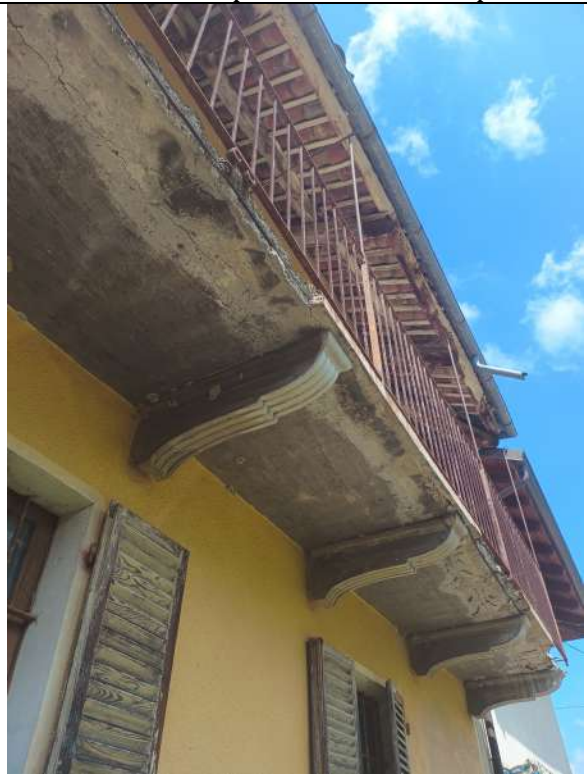
Foto 19_Vista verso balcone piano primo (su prospetto sud)
