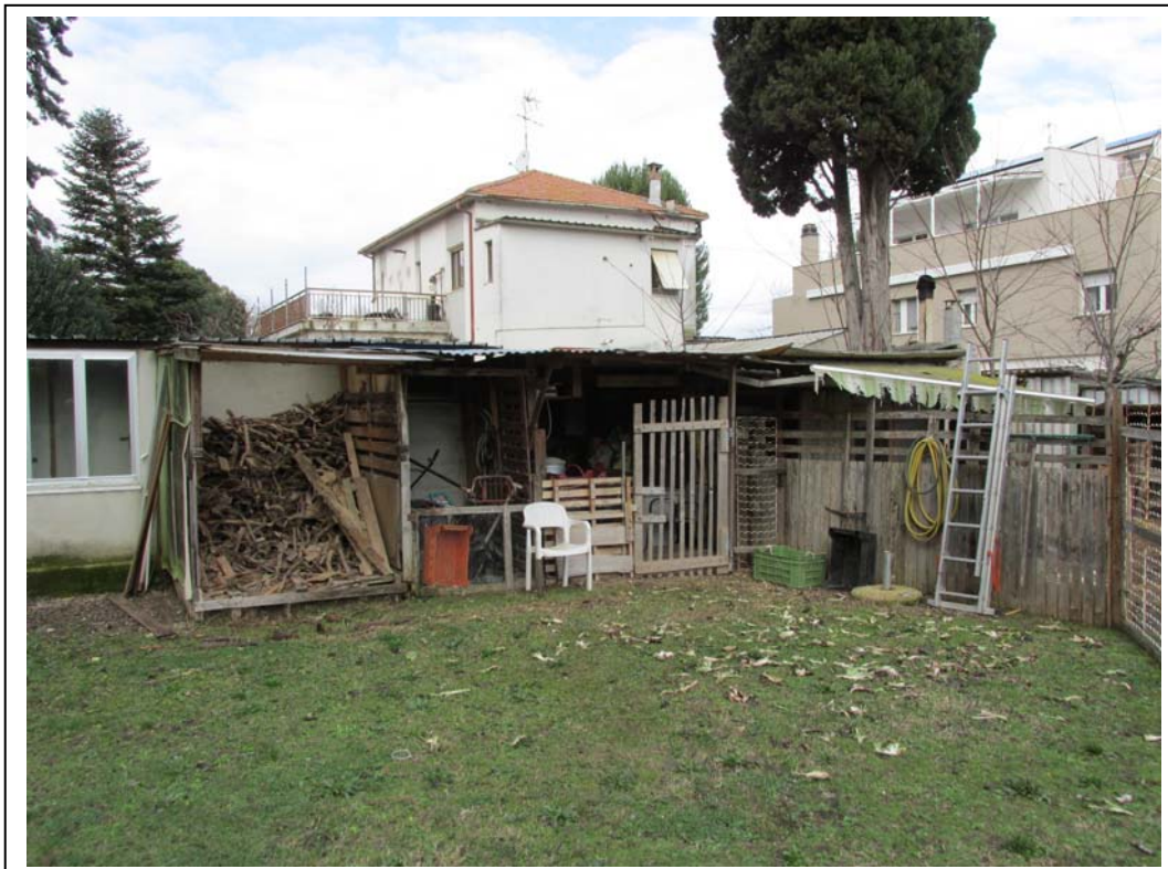
TERRENO (PARTIC 76) CON MANUFATTI ABUSIVI
