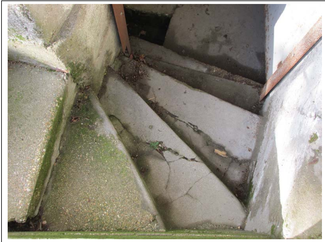
SCALA DI ACCESSO AL PIANO S1
