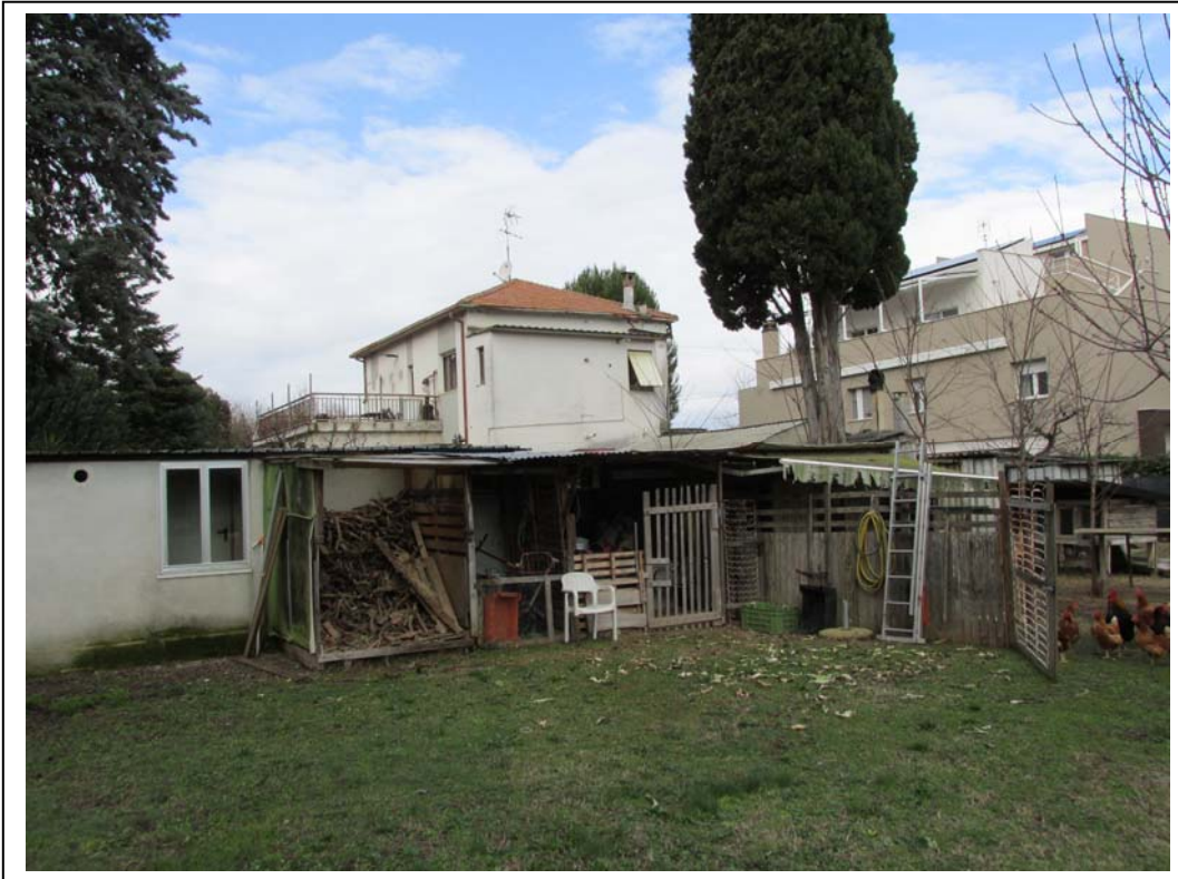
TERRENO (PARTIC 76) CON MANUFATTI ABUSIVI
