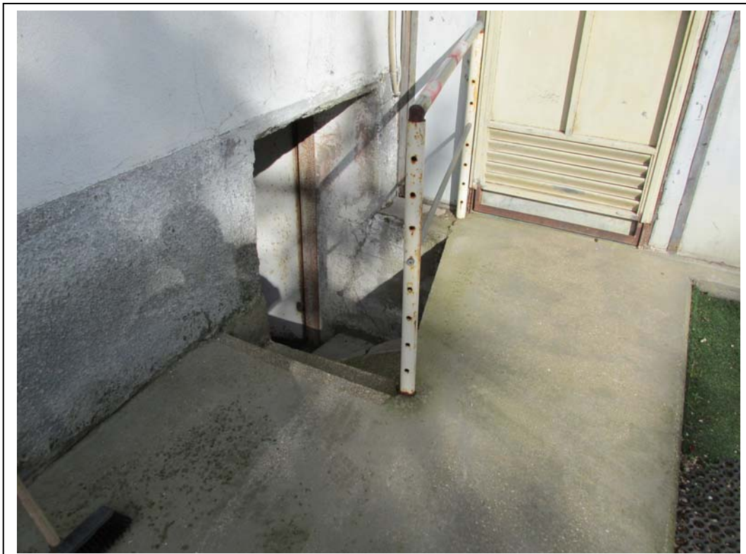
SCALA DI ACCESSO AL PIANO S1
