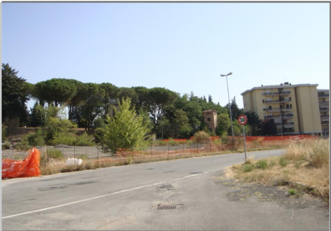
Foto n° 2 Zona cantiere extra comparto
