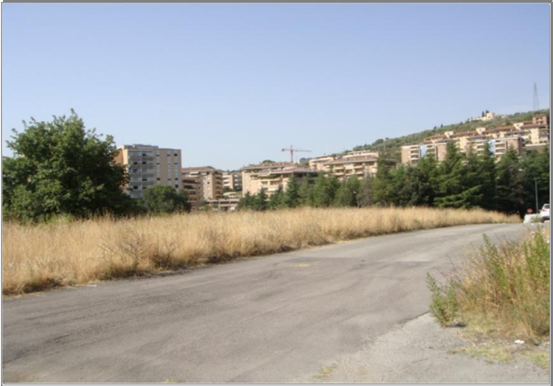
Foto n° 3 Strada perimetrale di lottizzazione
