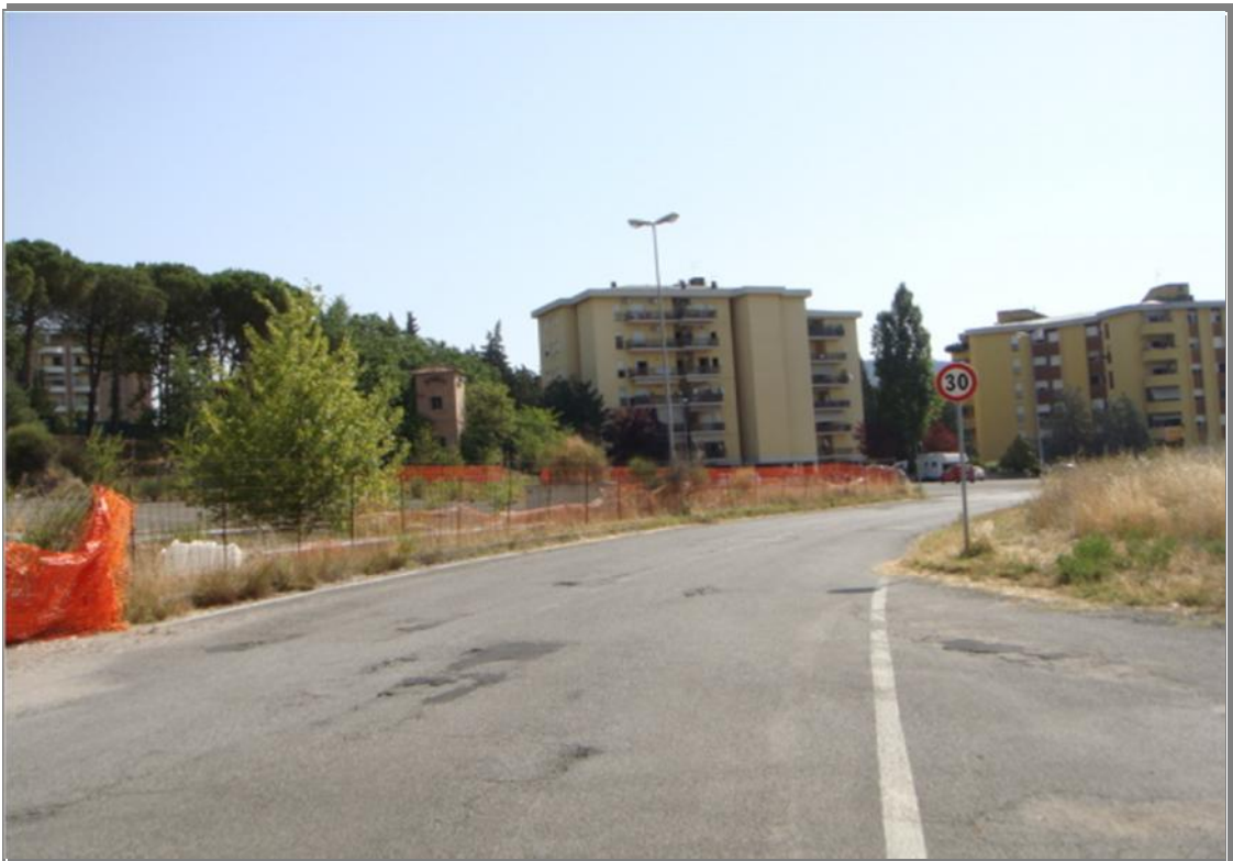
Foto n° 4 Strada perimetrale di lottizzazione
