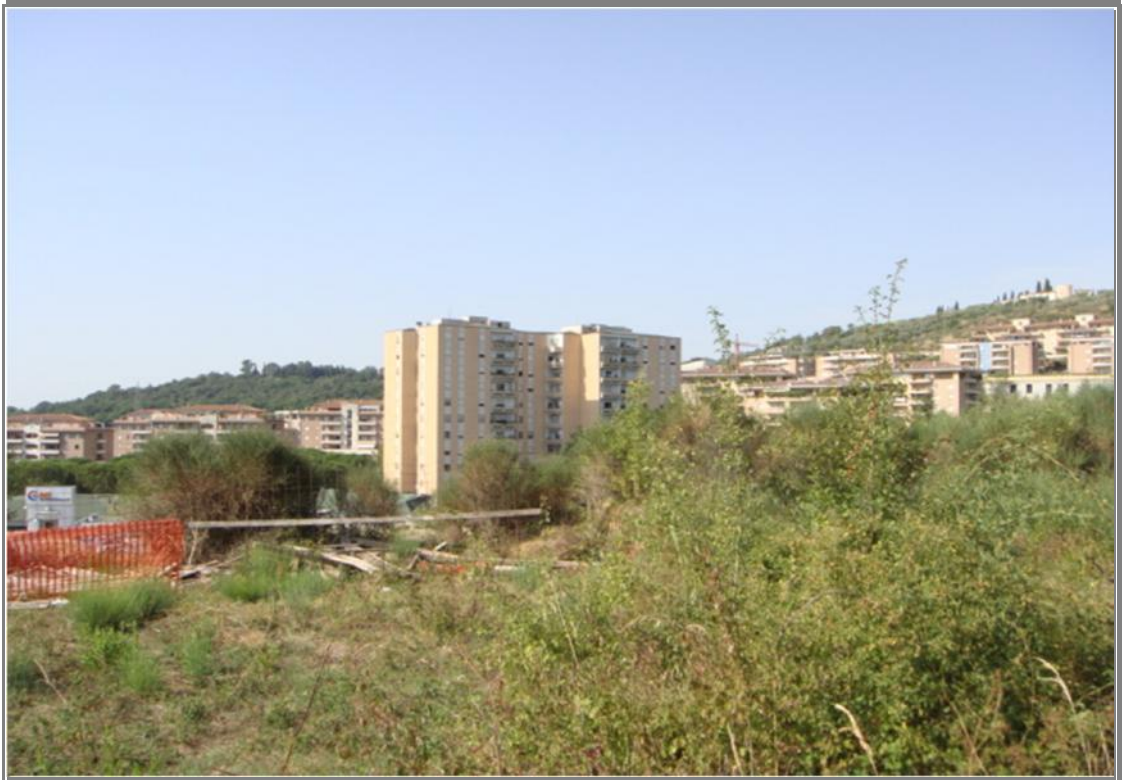
Foto n° 1 Ingresso al cantiere edile
