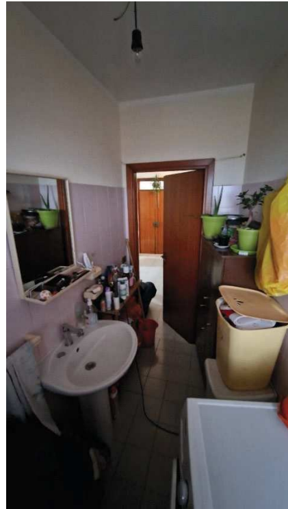
Foto 8. WC a servizio del piano terra
