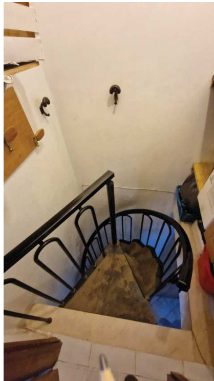
Foto 24. Scala di collegamento tra piano terra e S1
