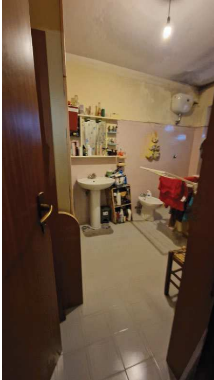
Foto 19. Accesso al WC a servizio del piano primo
