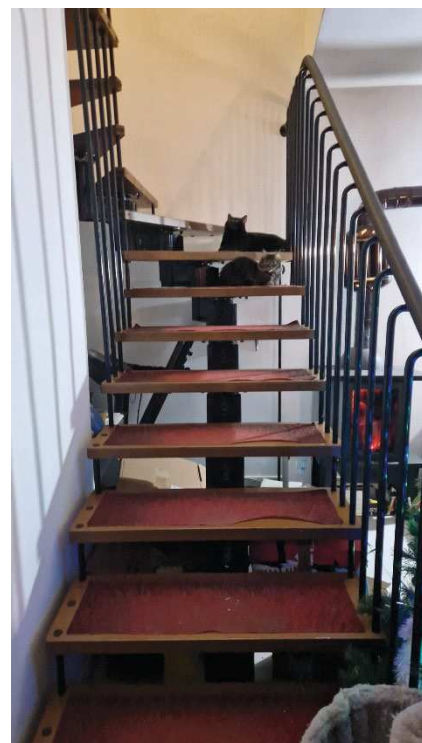
Foto 6. Particolare scala in legno e metallo
