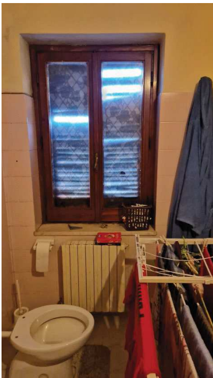
Foto 21. Particolare degli infissi interni in legno
