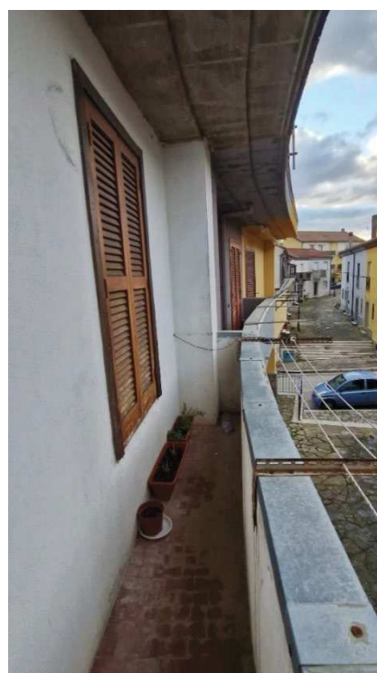
Foto 18. Balcone al piano primo
