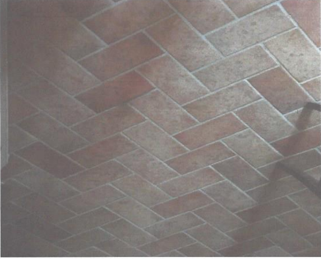
FOTO n. 7 - Pavimento in mattonelle di graniglia al piano primo
