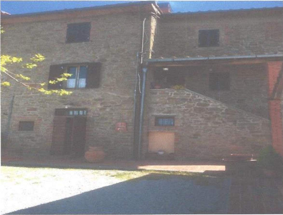
FOTO n. 1 - Ingresso di accesso al piano terra
