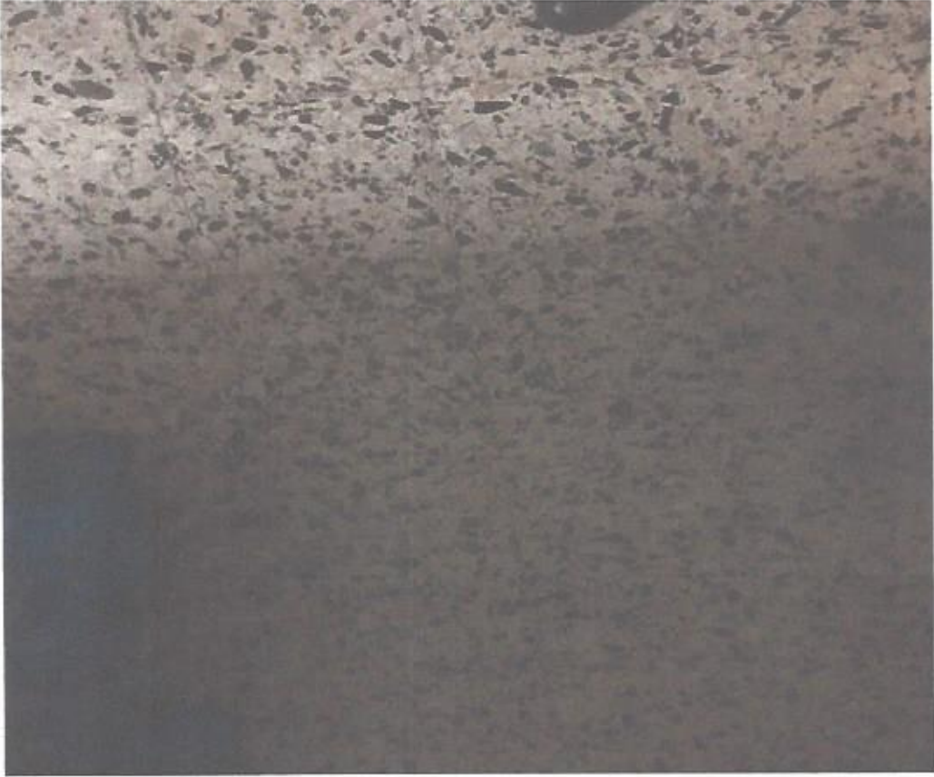
FOTO n. 7 - Pavimento in mattonelle di graniglia al piano primo
