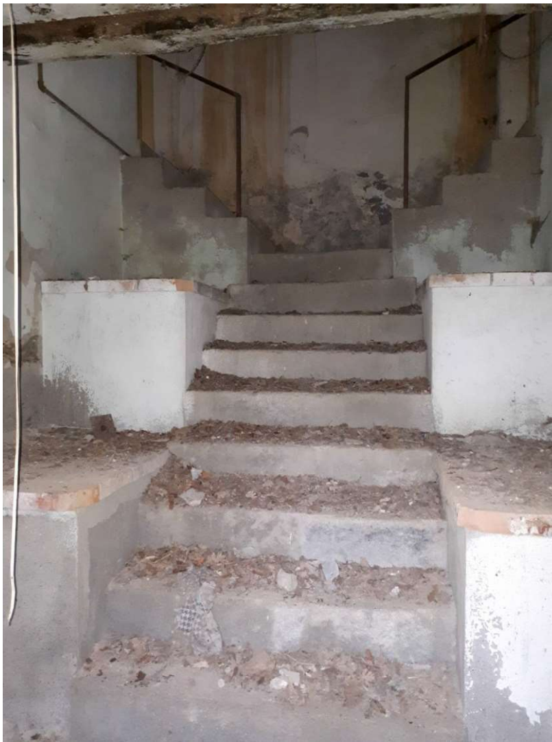
FOTO 9 – VISTA INTERNA – VANO SCALA
