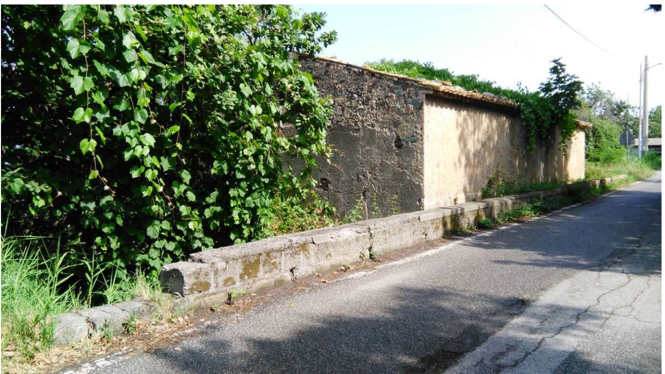
FOTO 4 – FABBRICATI RURALI - VISTA FACCIATE SUD/EST
