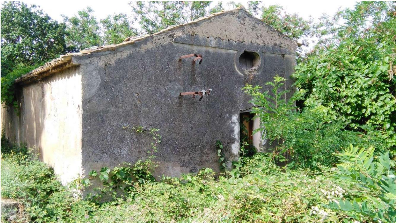
FOTO 3 – FACCIATA LATO NORD
