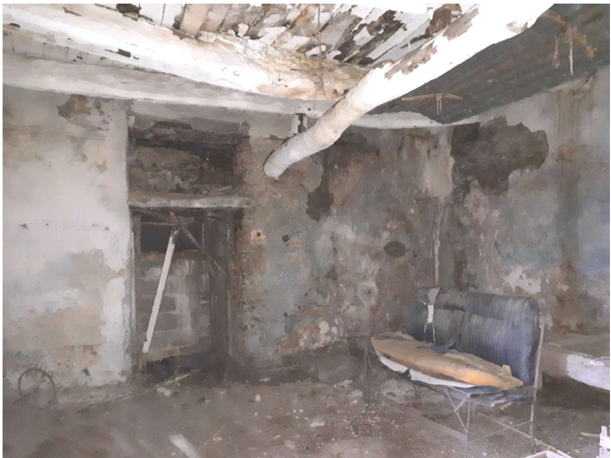
FOTO 10 – VISTA INTERNA – ALTRO VANO
