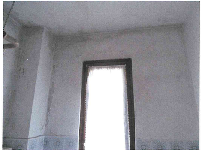
Foto 22 - Alloggio int. - bagno presenza efflorescenze
