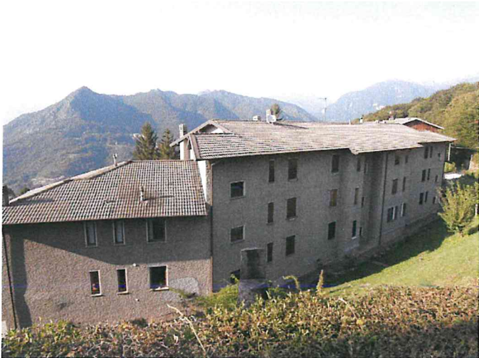
Foto 01 - Vista d'insieme fabbricato
