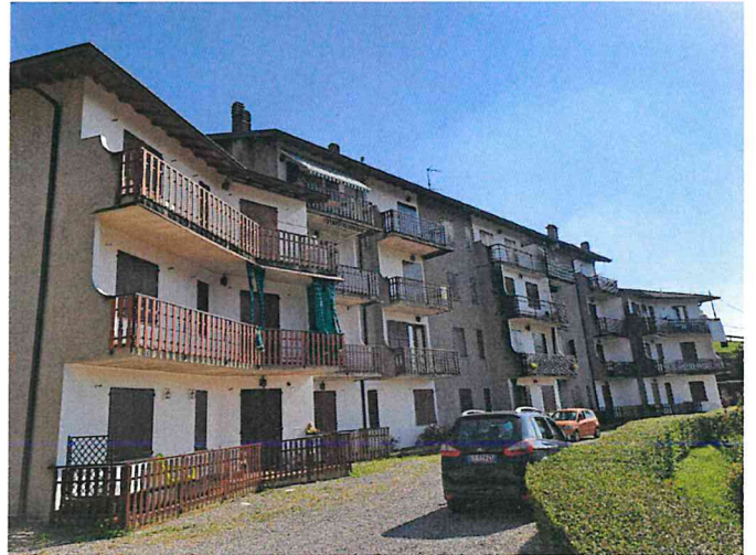
Foto 02 - Vista d'insieme fabbricato - Prospetto Nord-Ovest
