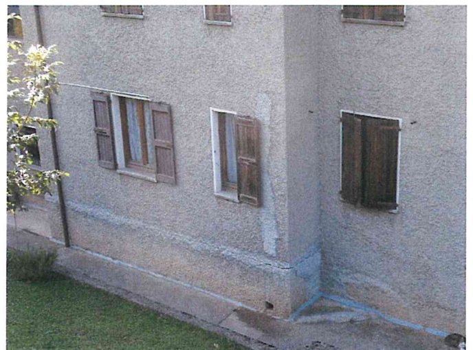
Foto 06 - Alloggio - Prospetto Sud-Est
