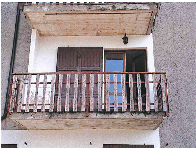
Foto 05 - Alloggio - Prospetto Nord-Ovest
