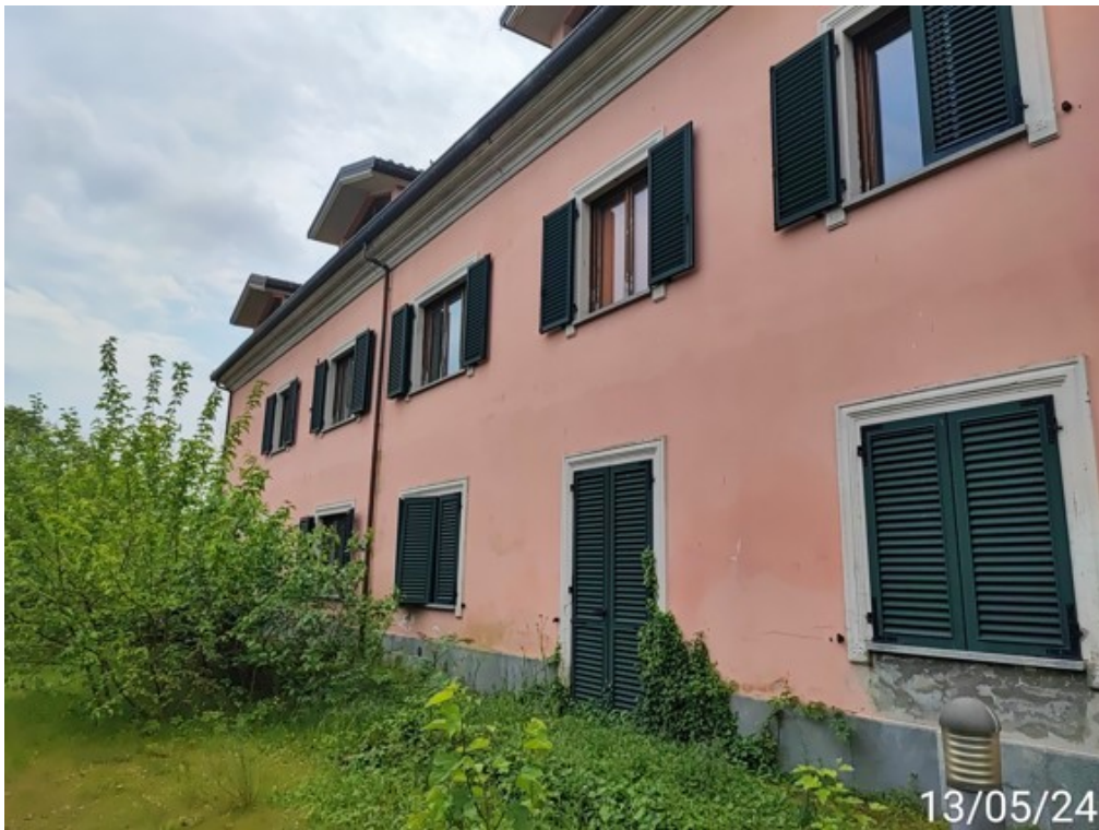
Fotografia E.5 - 6 Vista Prospetto Sud
