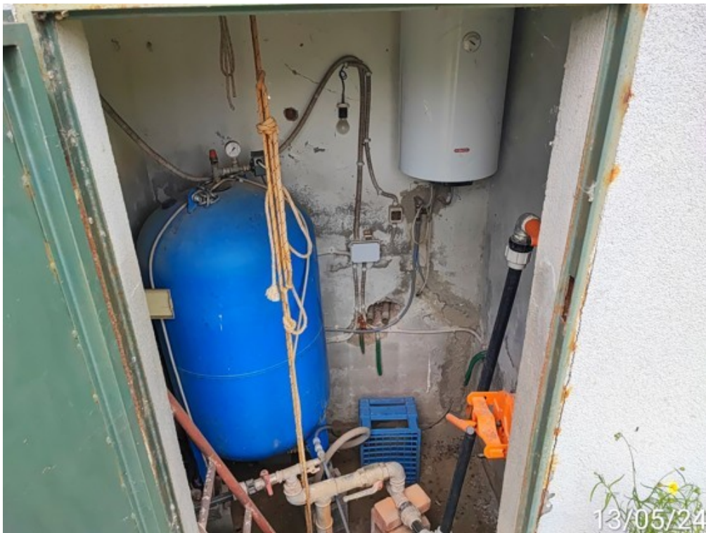
Fotografia E.38 - 39 Fabbricato ad uso locale tecnico
