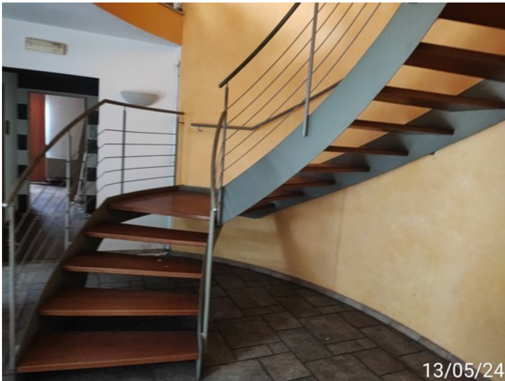
Fotografia E.8 - 9 Vano Scala (sub 10)
