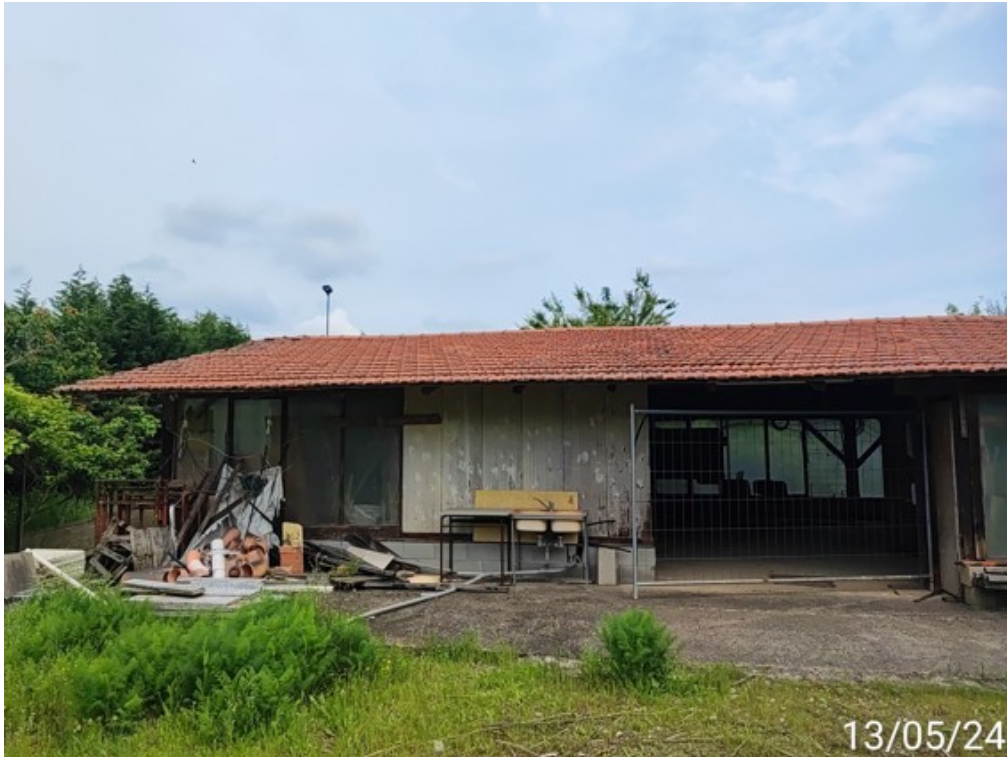
Fotografia E.39 - 40 Fabbricato da demolire
