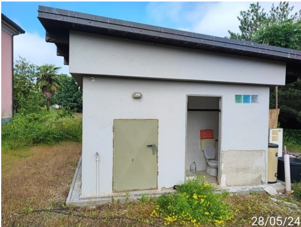
Fotografia E.36 - 37 Fabbricato ad uso locale caldaia
