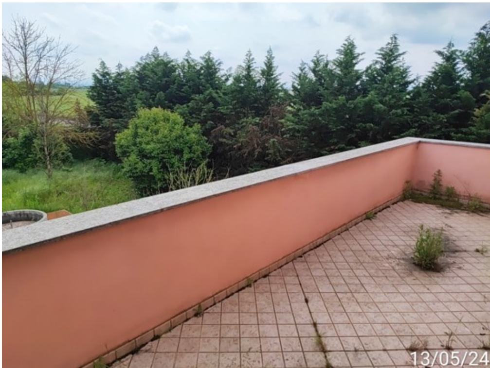
Fotografia E.32 - 33 Terrazza sopra Veranda da demolire
