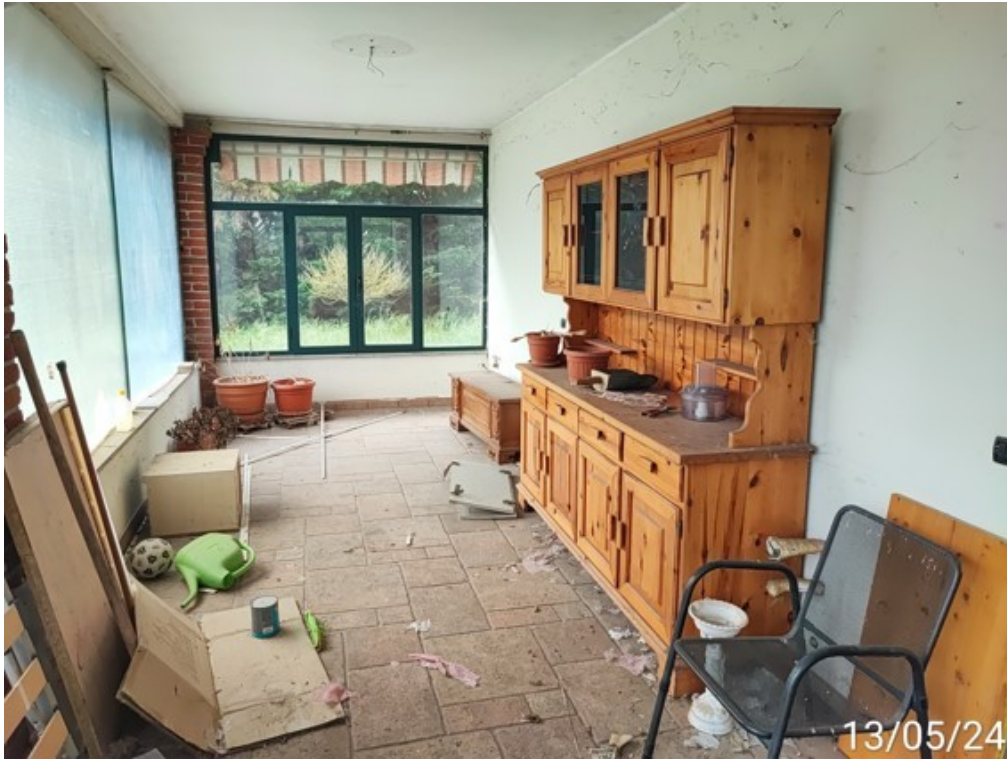
Fotografia E.31 - 32 Veranda Appartamento da demolire
