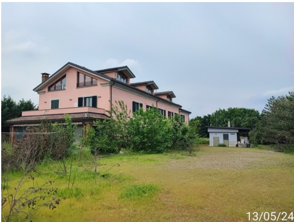
Fotografia E.2 - 2 Vista prospetto Nord-Est
