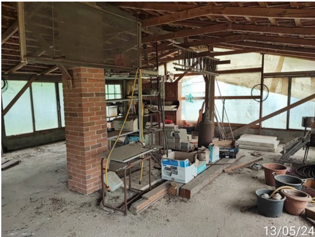
Fotografia E.40 - 41 Interno fabbricato da demolire
