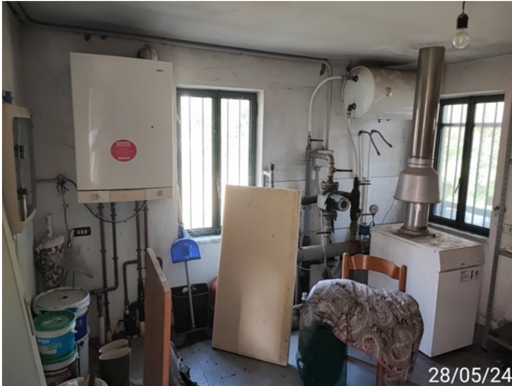
Fotografia E.37 - 38 Fabbricato ad uso locale tecnico
