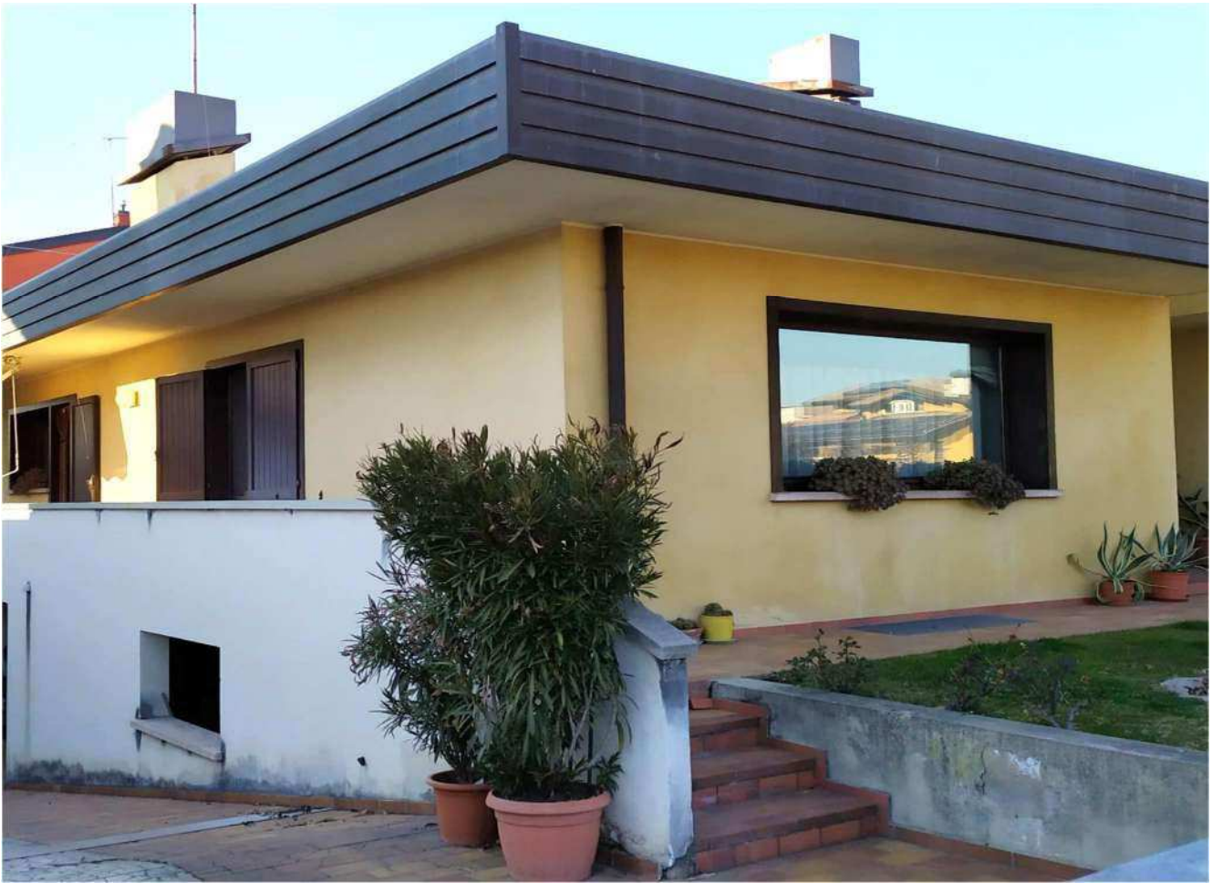
Veduta esterna della abitazione verso il garage Parete sotto il terrazzo da demolire
