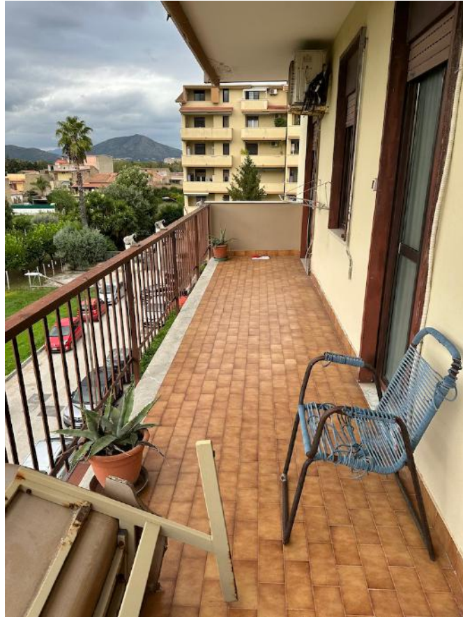
foto n.º9 – particolare balcone lato Ovest
