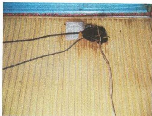
impianto elettrico, con cavi elettrici vecchi e non a norma
