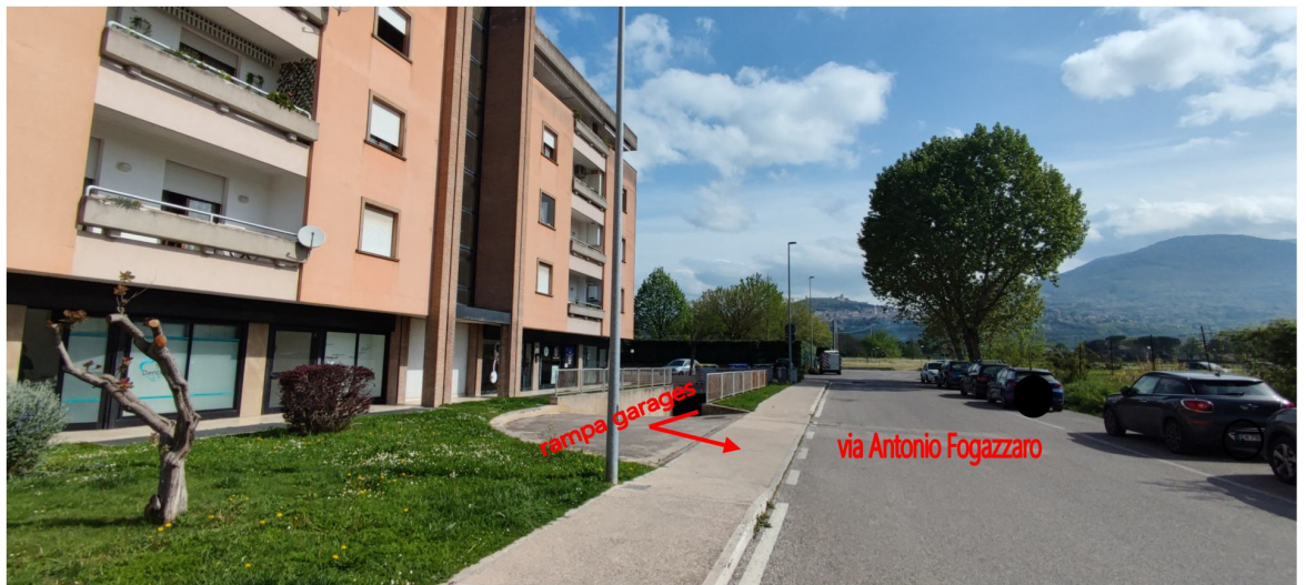
Foto 2 = edificio condominiale – rampa garages
