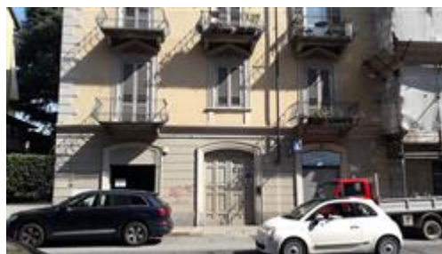
FACCIATA CORSO CASALE
