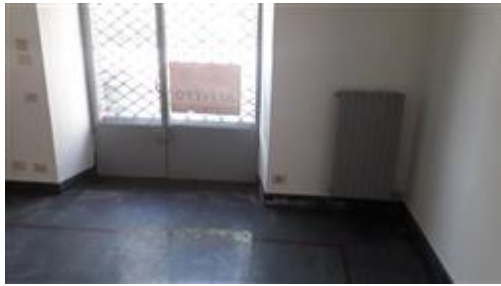
PORTA INGRESSO NEGOZIO LATO STRADA
