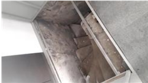
BOTOLA ACCESSO CANTINA
