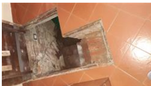
BOTOLA ACCESSO CANTINA
