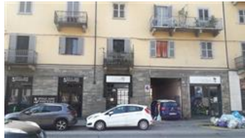
FACCIATA CORSO CASALE 104
