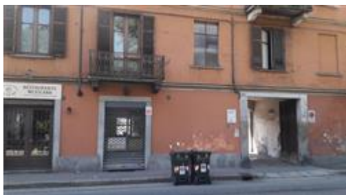
FACCIATA CORSO CASALE
