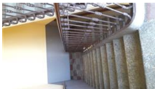
VANO SCALA CONDOMINIALE
