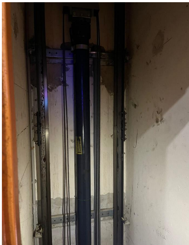
Struttura portante vano corsa
