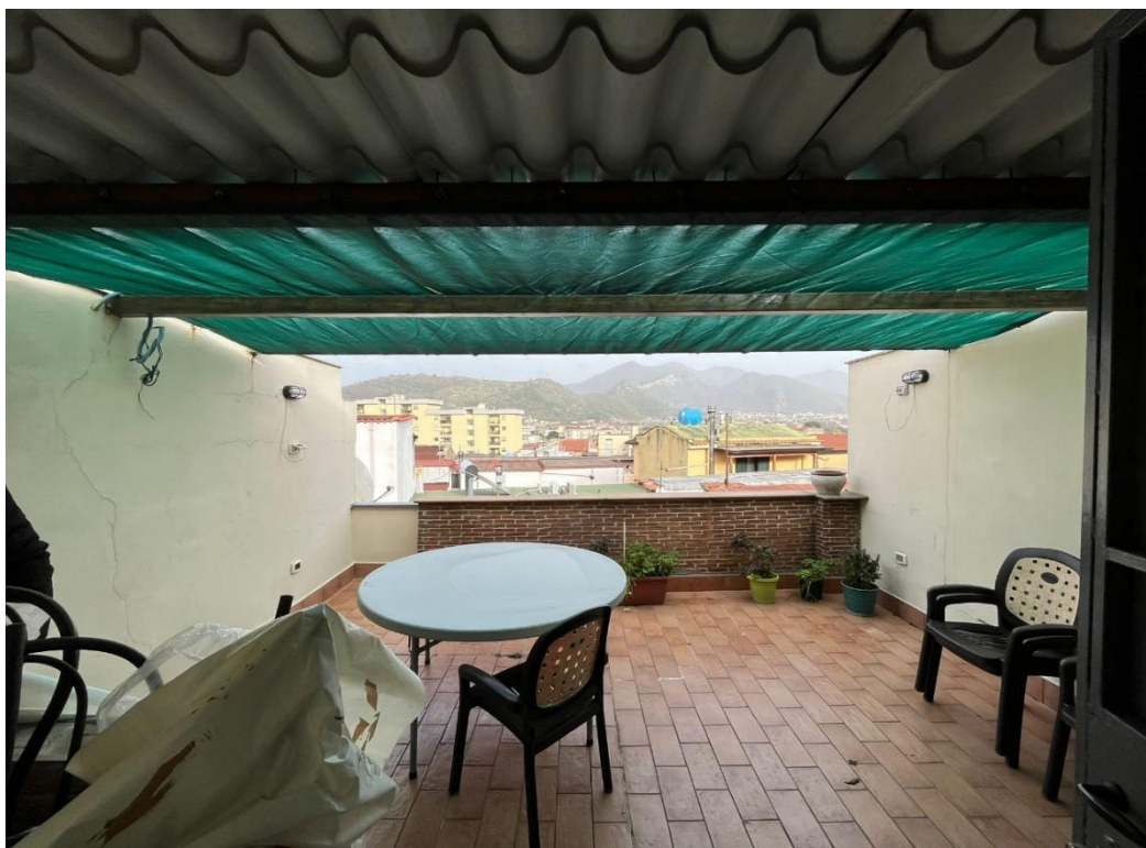
Vista del lastrico solare
