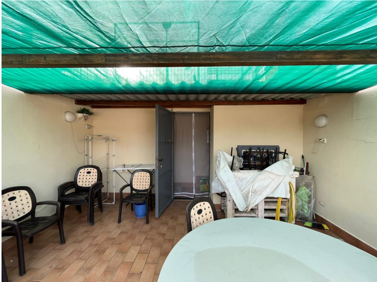
Vista del lastrico solare con particolari costruttivi della copertura
