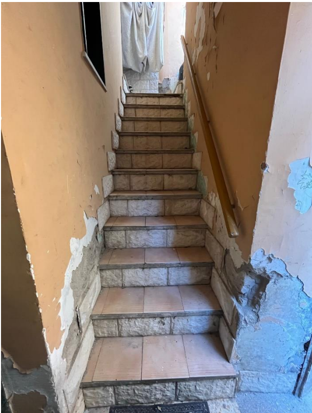
Rampa scale interna
