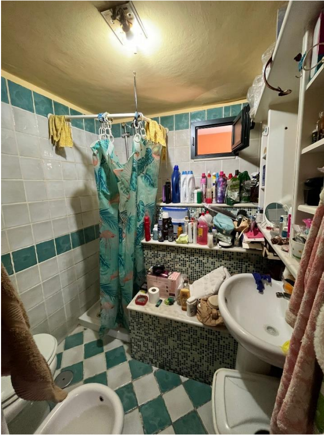
Vista interno bagno_1
