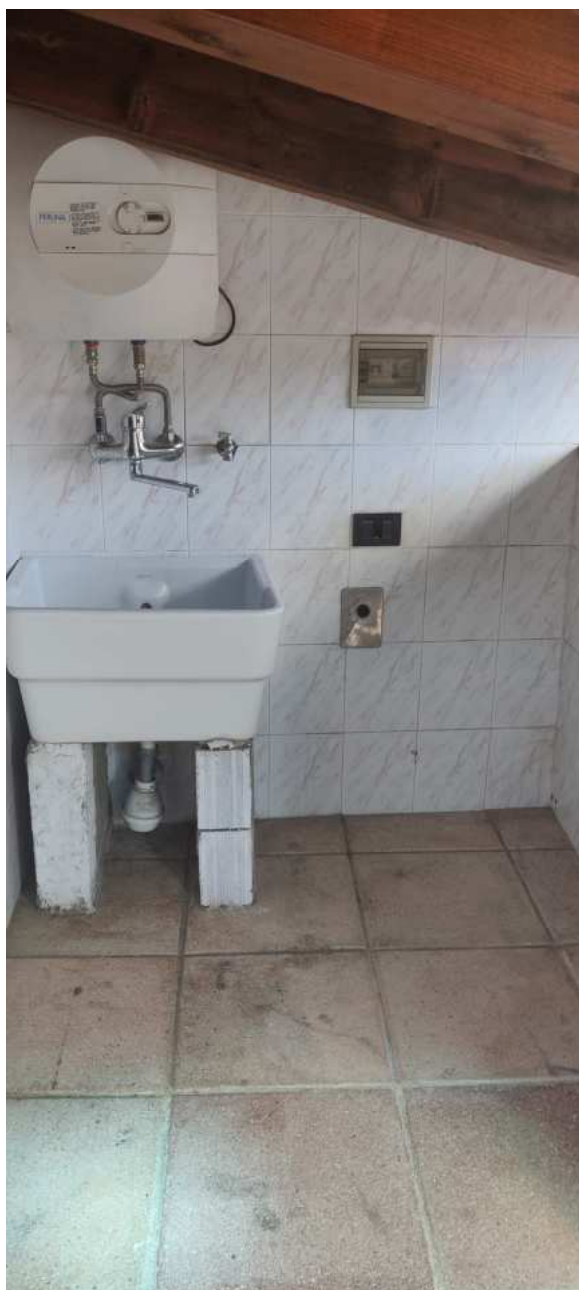
Foto n° 19 – Vista del ripostiglio che conduce alla terrazza
