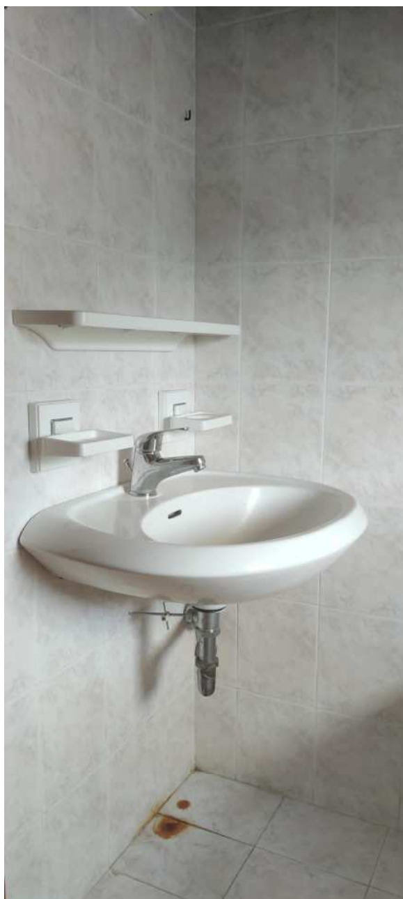
Foto n° 18 – Vista del bagno
