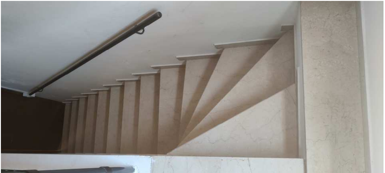
Foto n° 08 – Vista della scala interna che dall'unità sub. 5 (non eseguita) conduce al sub. 6
