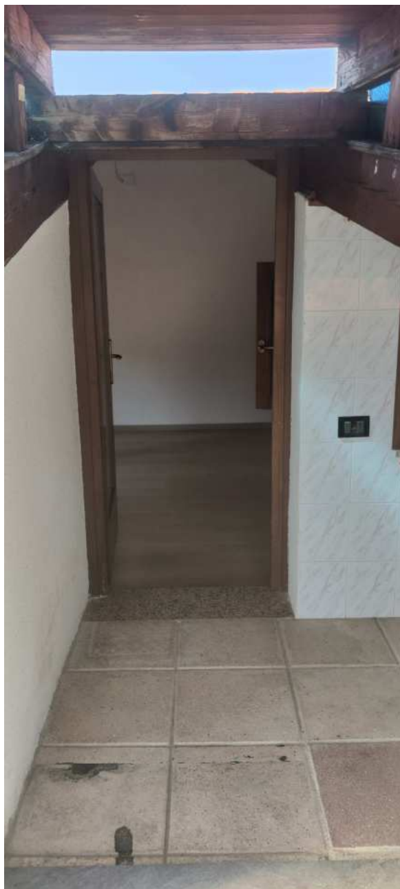
Foto n° 26 – Vista del passaggio dalla terrazza all'interno dell'unità abitativa
