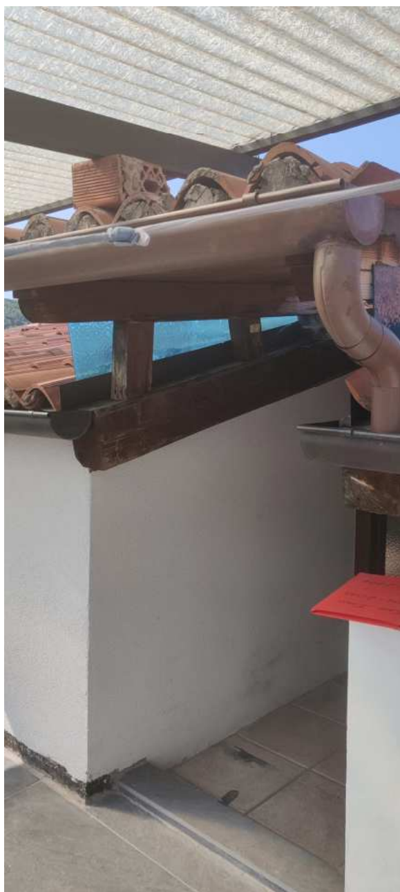
Foto n° 25 – Vista del passaggio dalla terrazza all'interno dell'unità abitativa
