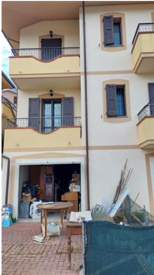
Retroprospetto e accesso garage
