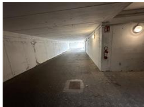
Corsia di manovra a piano interrato p.ed. 1073 C.C. Scurelle
