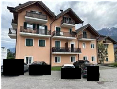
Vista esterna p.ed. 1073 C.C. Scurelle
