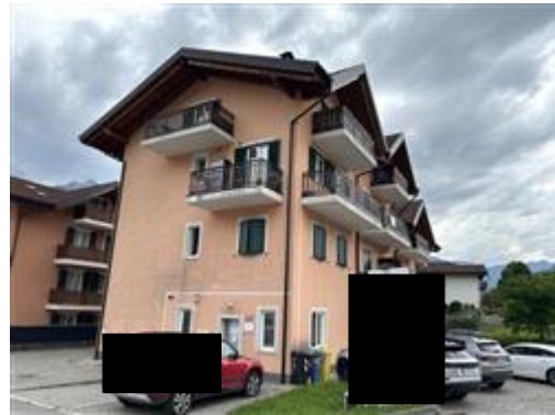
Vista esterna p.ed. 1073 C.C. Scurelle
