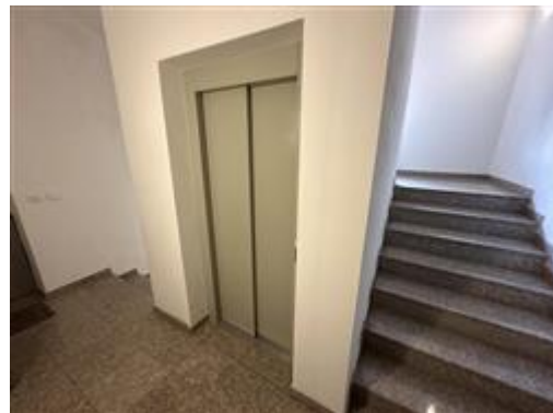
Vano scala con ascensore p.ed. 1073 C.C. Scurelle
