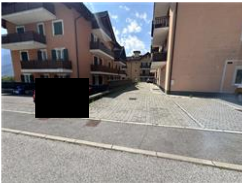
Vista esterna p.ed. 1073 C.C. Scurelle
