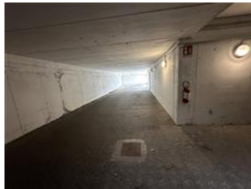
Corsia di manovra a piano interrato
