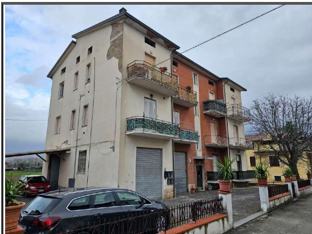
Foto n. 1 Vista del fabbricato di cui gli immobili pignorati fanno parte.
