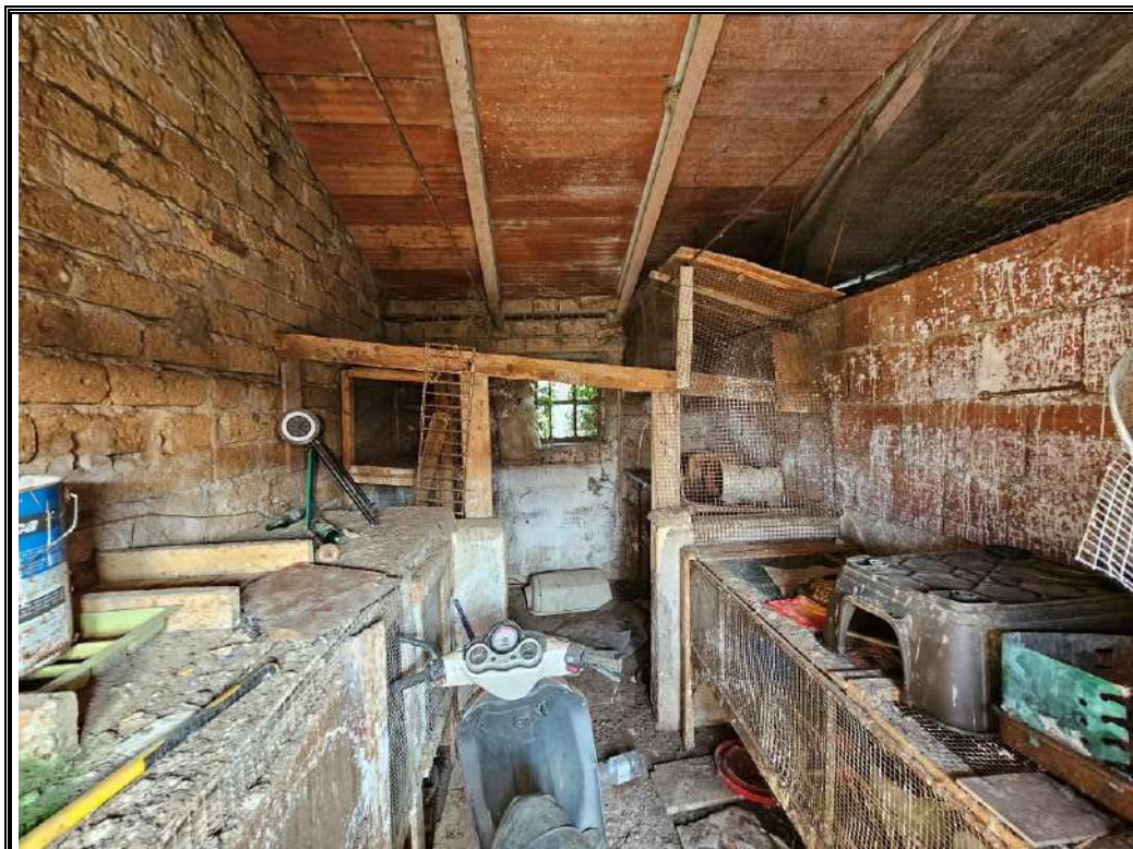
Foto n. 25 Vista del locale.
