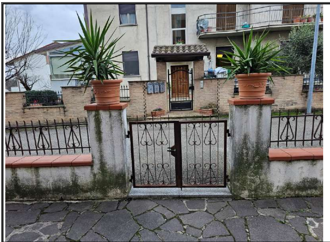
Foto n. 4 Particolare dell'accesso pedonale alla corte della palazzina.
