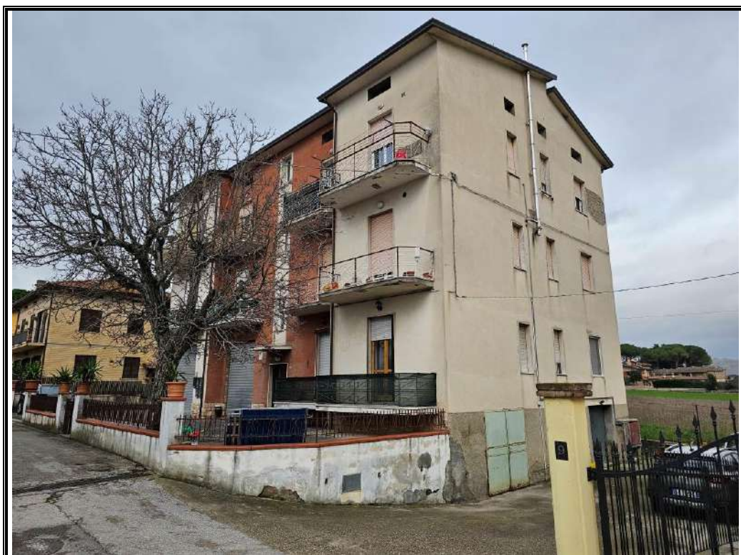
Foto n. 2 Vista del fabbricato di cui gli immobili pignorati fanno parte.
